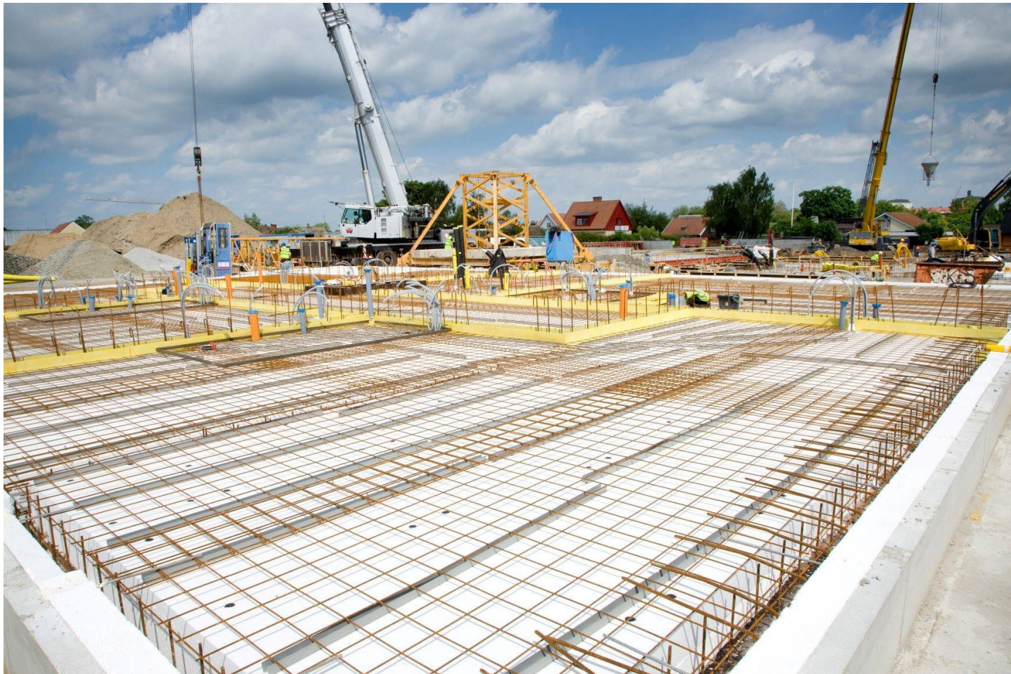
Byggarbetsplats i Eslöv
