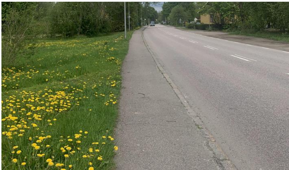
Figur 26: Gångbana med granitkantstöd inom Billinge tätort
