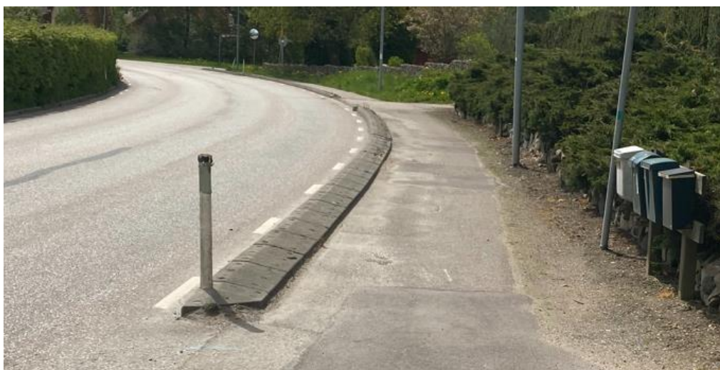
Figur 27: Gångbana med GCM-kantstöd i norra delen inom Billinge tätort
