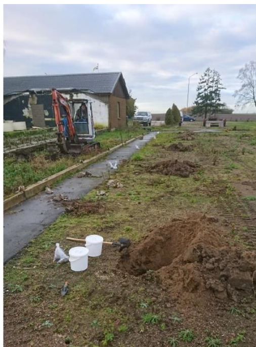
Figur 3 Maskingrävning av provgropar för delprov till samlingsprov SA i östra delen av fastigheten där de äldsta växthusen legat.
