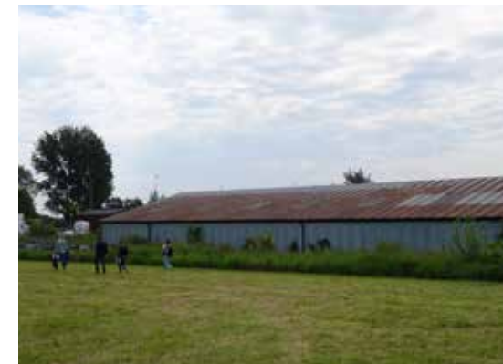
Byggnad skapar gräns mot område i söder.
