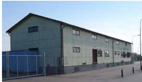
Något högre bebyggelse i det mindre industriområde som är beläget närmast järnvägen.
