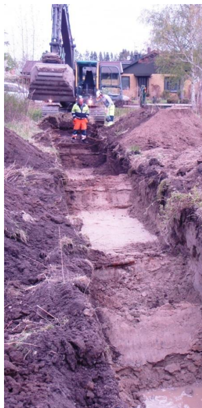
Figur 2. Schaktdikesgrävning på fastigheten Getinge 11:5
