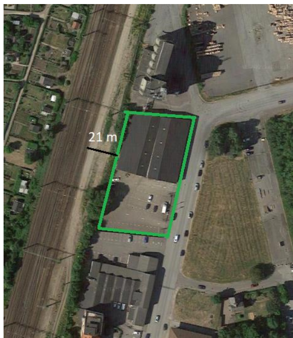
Figur 2: Avstånd mellan fastighetsgräns och spår 6, Södra stambanan.
