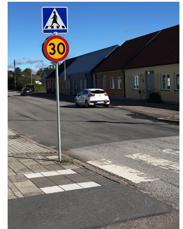
Nedsänkt kant vid övergångsställe.
