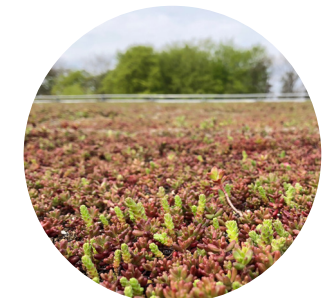
Sedum på delar av taken
