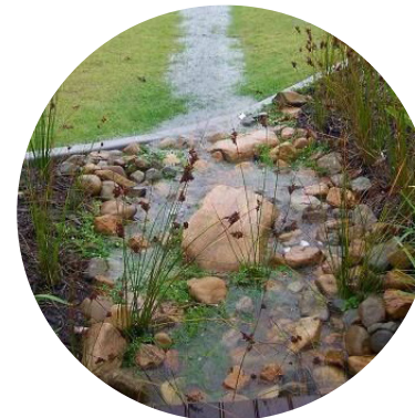
Fördröjning av dagvatten i raingardens
