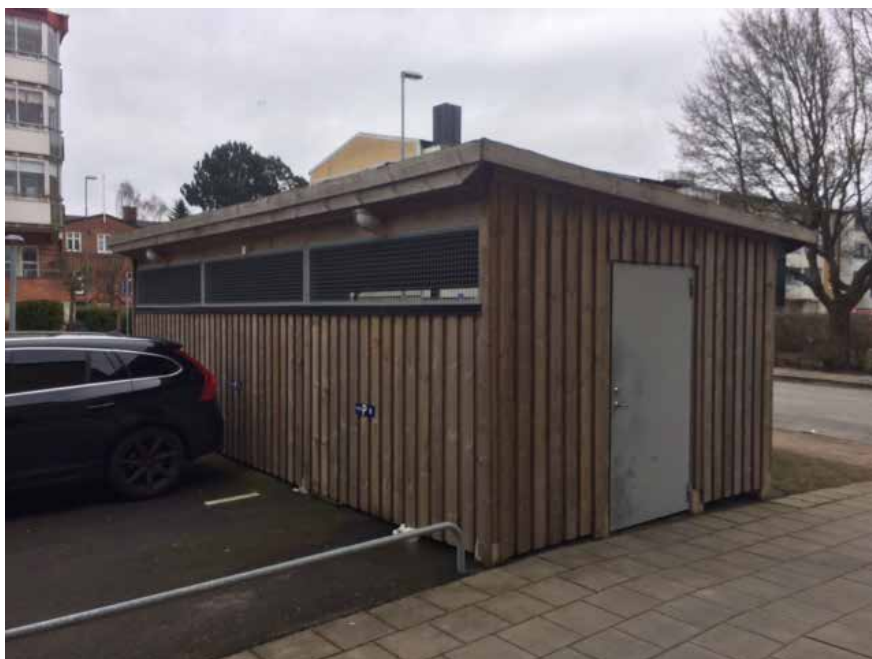
Nuvarande miljöstationen till bostadsfastigheten.
