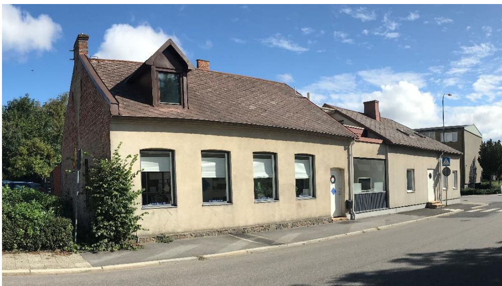
Befintlig bebyggelse inom planområdet sett från Repslagaregatan
