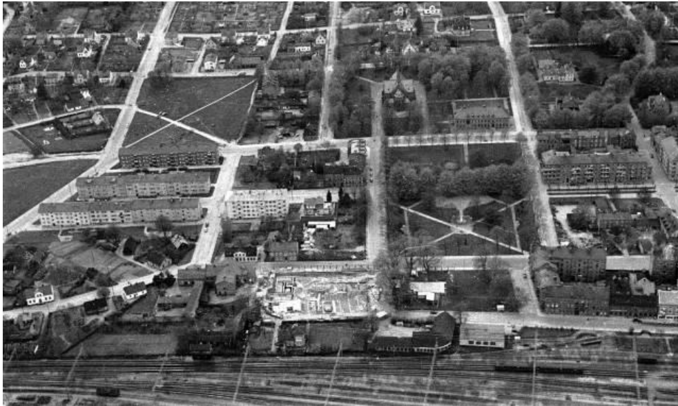
Flygbild över Eslöv när Medborgarhuset byggdes. Bild från Eslövs bildarkiv, KG pressfoto bildsamling
