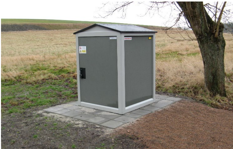
Figur 10. Befintlig kopplingsstation.
