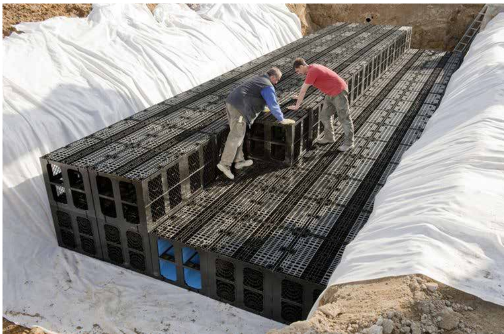
Installation av dagvattenkassett för fördröjning av dagvatten. Bild; Tyréns AB.
