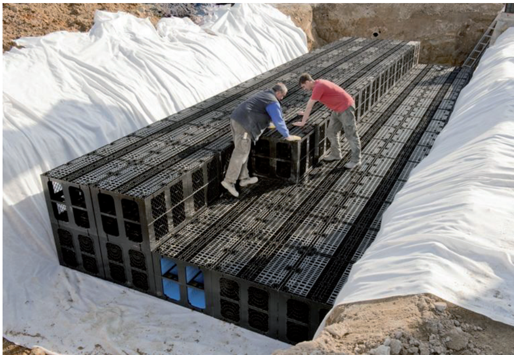
Installation av dagvattenkassett för fördröjning av dagvatten. Bild; Tyréns AB.
