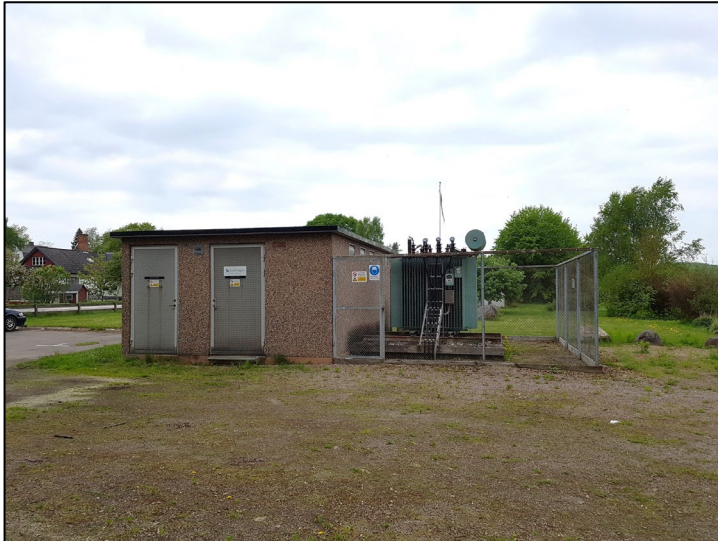
Bild 4. Befintlig transformatorstation, Röstångavägen till vänster i bilden.
