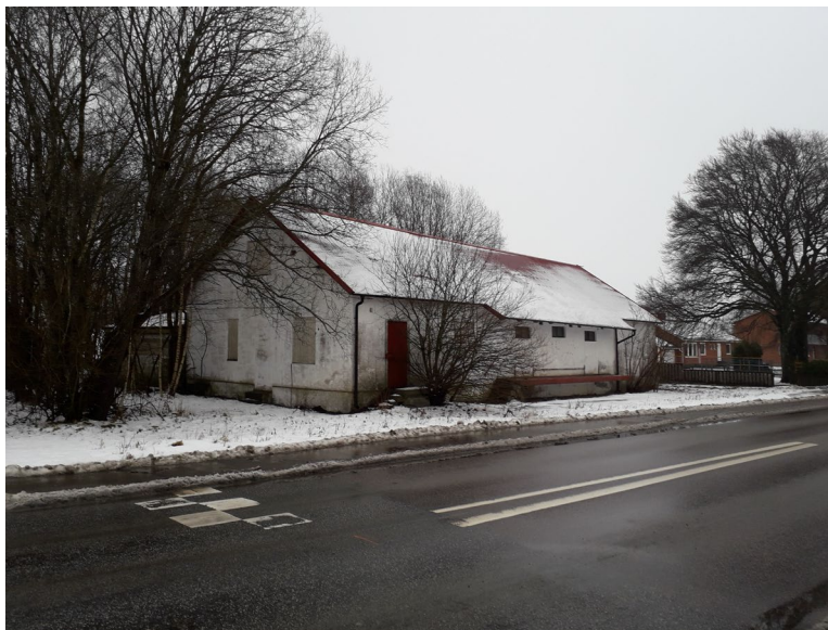
Bild 9. Del av mejeribyggnaden som vetter mot Röstångavägen.
