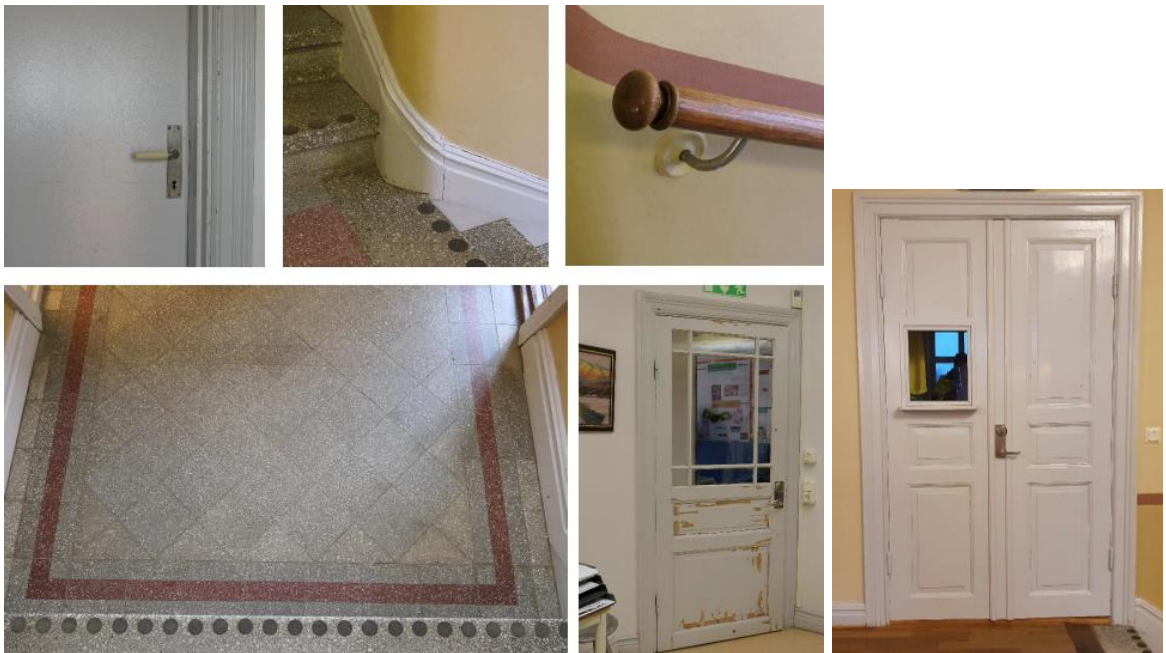
Originaldetaljer i det södra trapphuset; dörrfoder, sockellist, ledstång, klinkergolv i terrazzo, glasad innerdörr samt pardörr med lucka
