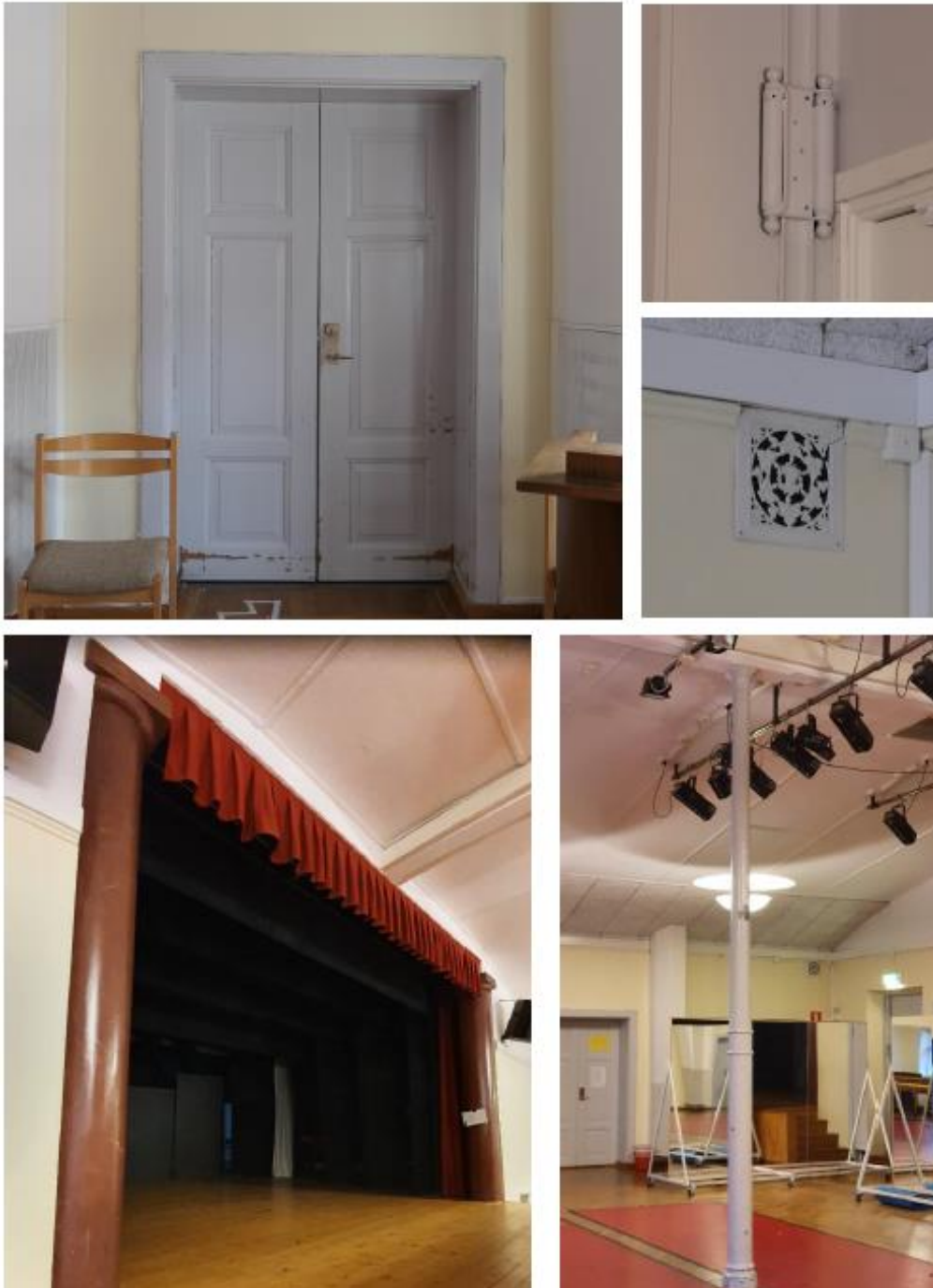
Ursprungliga detaljer i salongen; spegeldörrar, gångjärn från svängdörr, dekorativt ventilgaller och taklist, scen med marmorerade kolonner och mittkolonn.
