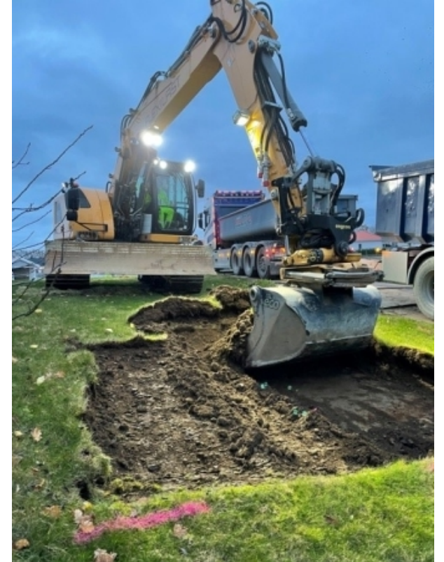
Bild: Sanering Stehag
