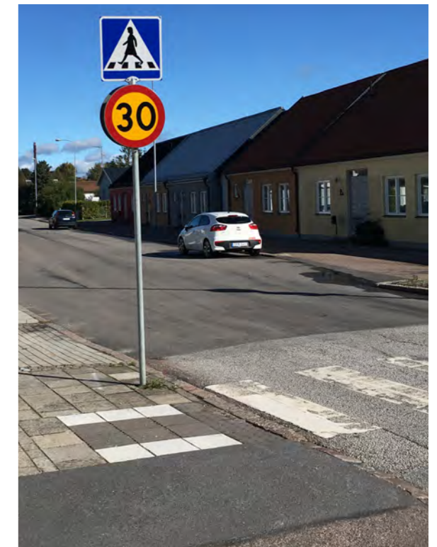
Nedsänkt kant vid övergångsställe.
