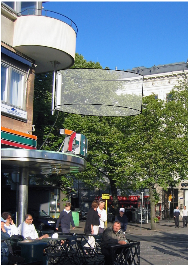
Det vita avlånga föremålet strax under balkongen är en basstation. Referensvärdet kan överskridas i området framför antennen (markeras av den genomskinliga cylindern).
