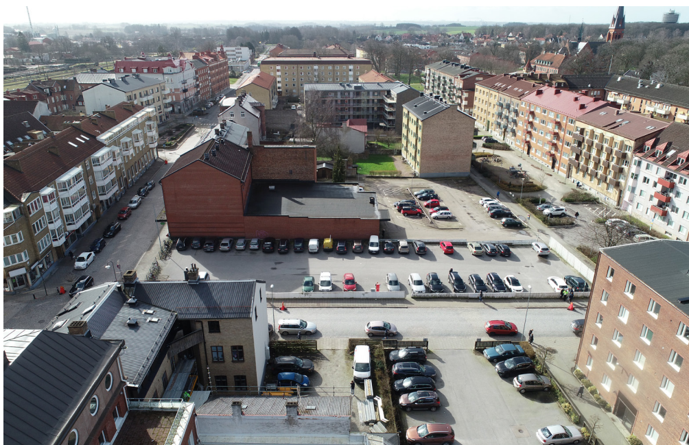
Vy över delar av planområdet mot söder
