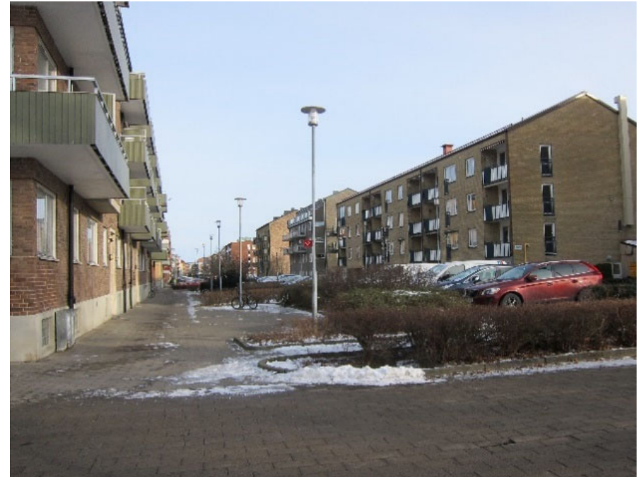
Figur 6: Befintlig belysning Trollsjögatan-Västergatan.
