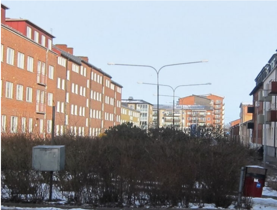
Figur 7: Befintlig belysning Västergatan-Föreningstorget.
