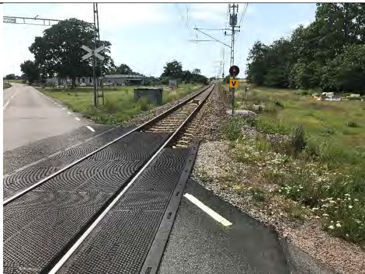
Figur 10 Väg 1274 korsningen med järnvägen
