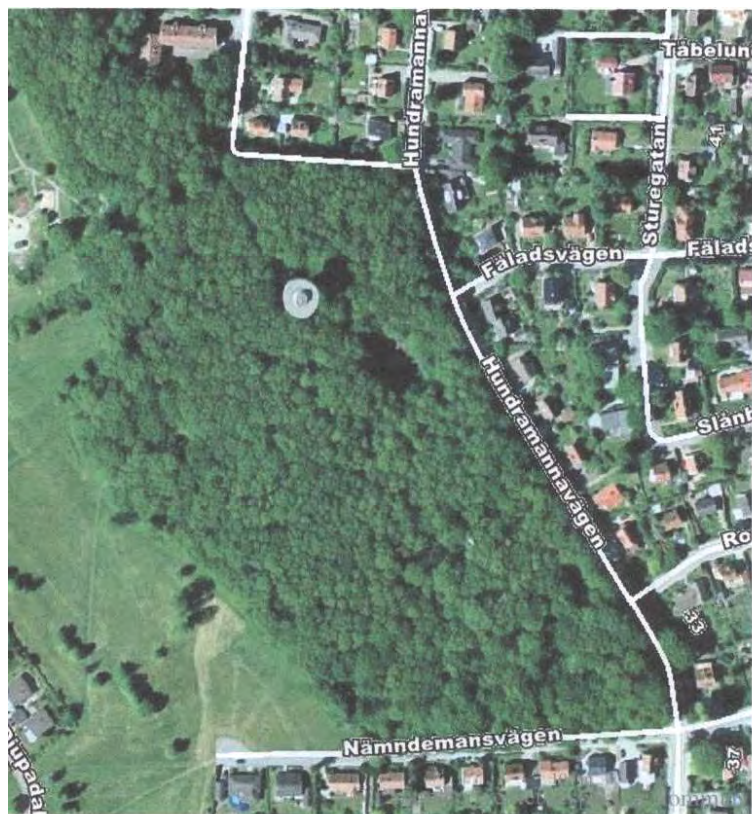
Figur 1. Flygbild över Allmänningen, Eslövs kommun. Stadens vattentorn ses i den norra delen av området.
