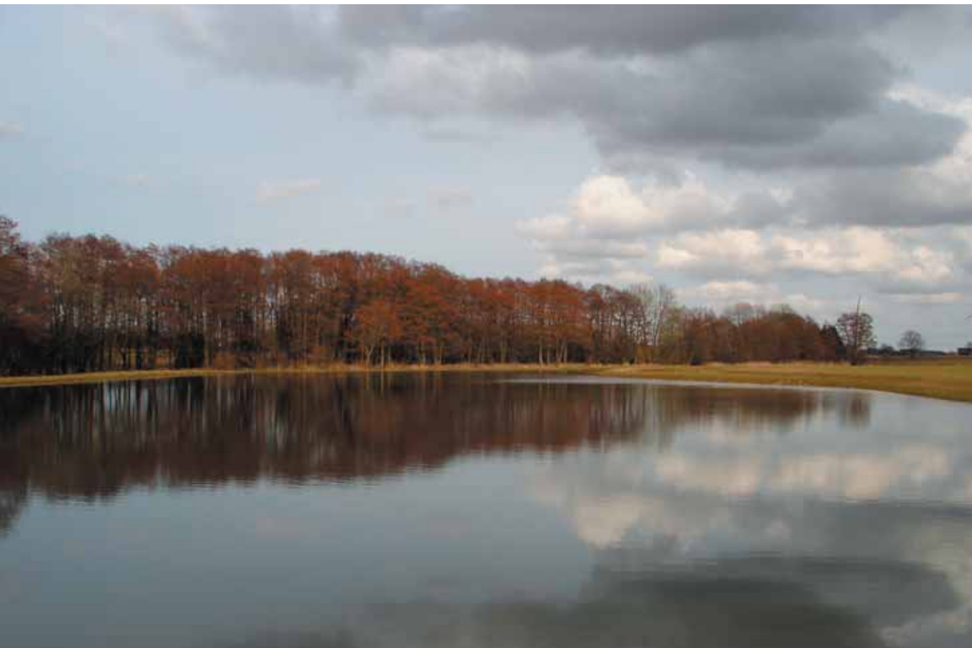
Anlagd damm vid Kyrkhult
