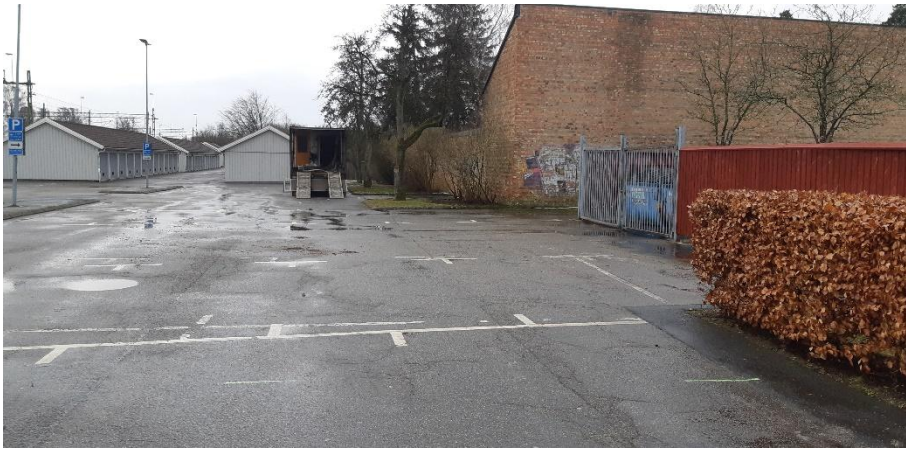
Figur 3.2. Asfalterad yta inom undersökningsområdet.
