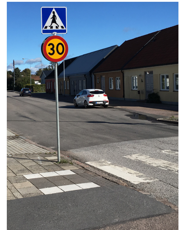
Nedsänkt kant vid övergångsställe.
