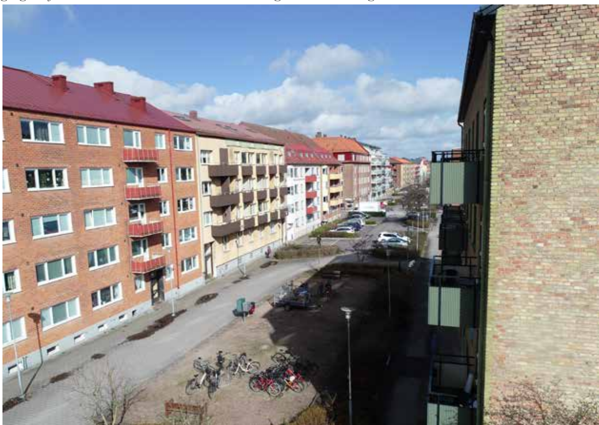
Närmast från vänster Skomakaren 20 och 11. Skomakaren 20 uppförd ca 1960 med rött tegel. Skomakaren 11 med gul puts, uppförd ca 1940. Med lägre rumshöjd har Skomakaren 20 uppförts med ytterligare en våning jämfört med Skomakaren 11. Detta trots att skillnaden mellan byggnadernasnockhöjd endast är cirka 1 meter.
