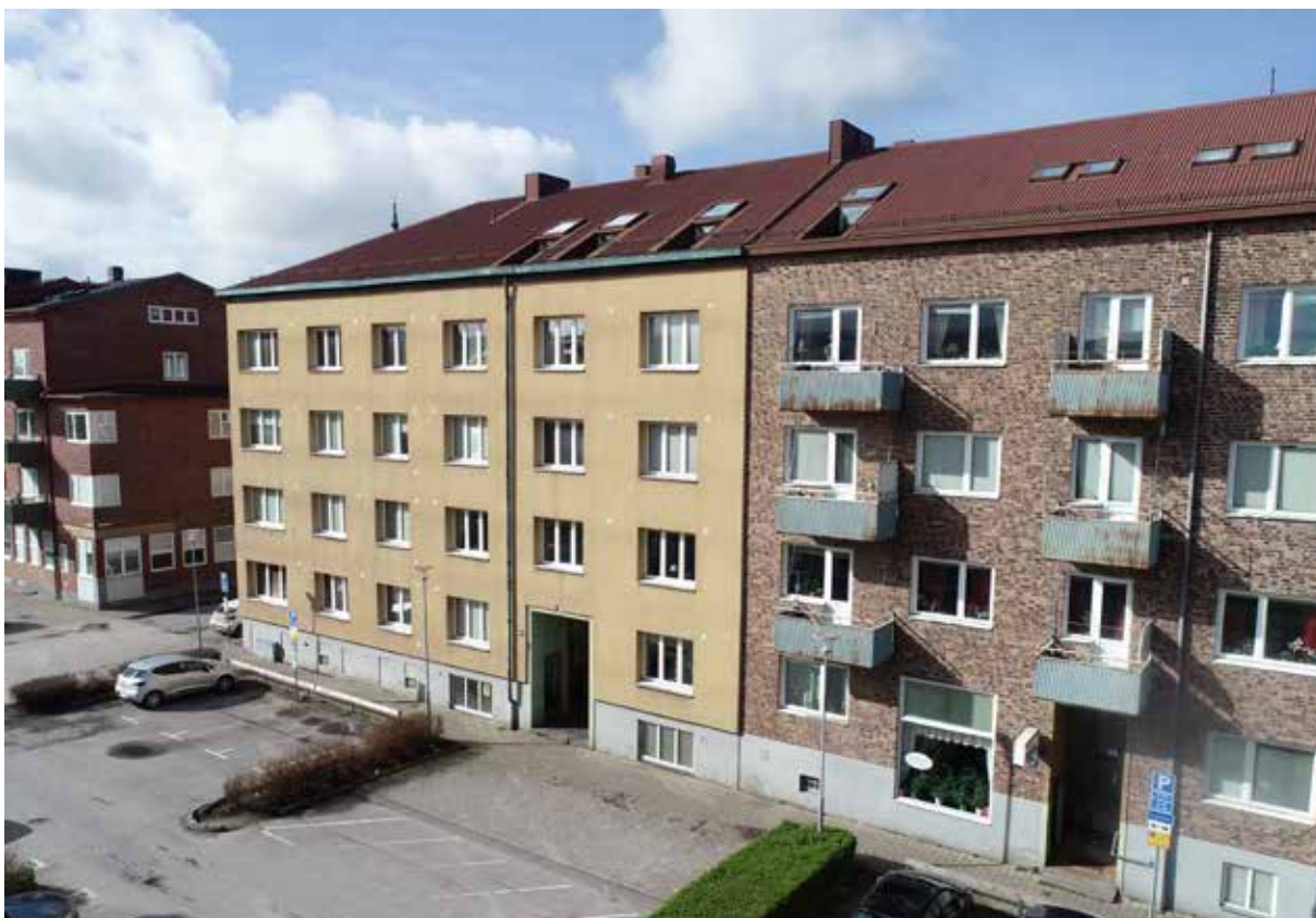
Skomakaren 9 och 15, uppförda under tidigt 1940-tal. Skomakaren 9 till vänster med gul puts och tilläggsisolering, troligen genomfört under 1970-talet. Skomakaren 15 till höger med rödbrunt tegel.
