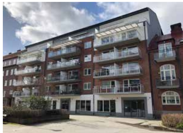
Målaren 8 uppförd under 2010-talet i rött tegel med bottenvåning i gråvit puts. Byggnaden har 5 våningar och en indragen 6:e våning. Nockhöjden är den samma som Målaren 5 till vänster.
