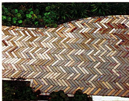
Tegelbeläggning med varierande ton läggs i fiskbensmönster på de huvudsakliga rörelseytorna framför huvudbyggnaden.
