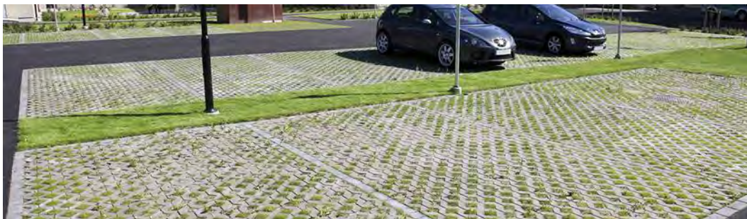
Figur 7-1. Parkeringsplats för bil utförd med gräsarmering som möjliggör för högre infiltration och mindre dagvattenavrinning (Benders 2019).
