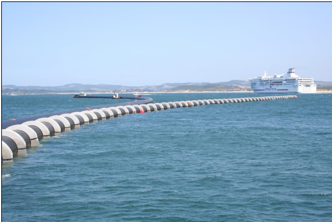
Figur 8-3. Exempel på en viktad och en oviktad tryckledning som ligger flytande inför transport till viktning och sänkningsplats.
