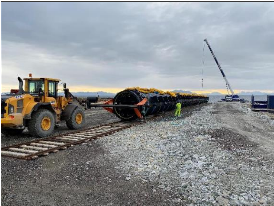
Figur 8-9. Sjösättning av PE-profilrör.
