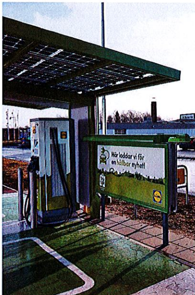
Figur 12. Utformning av laddplats för elbil.
