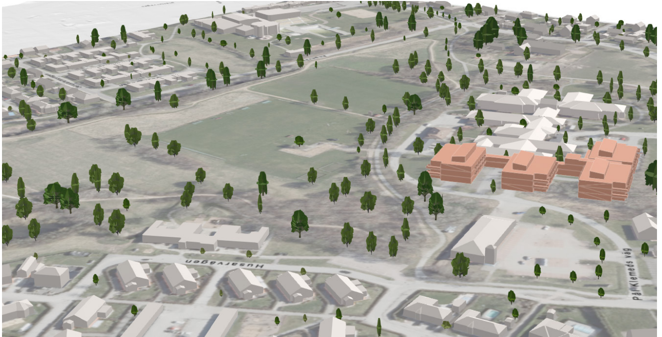
Alternativ 1. Vy från norr över den nya byggnaden.
