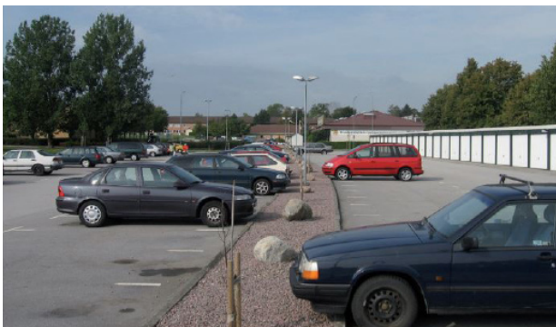
Vy över befintlig garagebyggnad och parkering.
