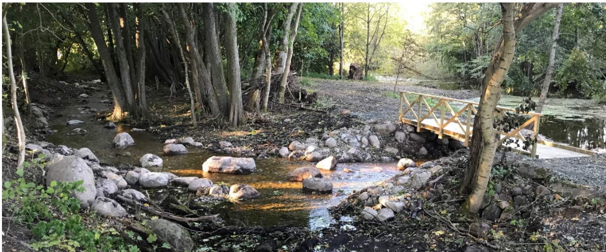
Ett omlöp har anlagts från kvarndammen vid Högseröd som bidrar till fria vandringsvägar för fisk och andra vattenlevande djur.
