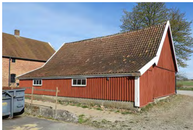
Traktorgaraget sett från söder.
