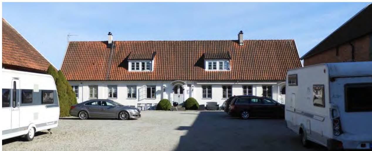
Mangårdsbyggnadens fasad mot gårdsplanen i söder.
