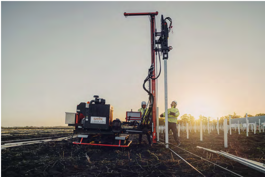
Figur 3.3: Montagesystem förankras med pålningsmaskin (©Svea Solar).
