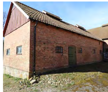
Svinstallets norra fasad och östra gavel.
