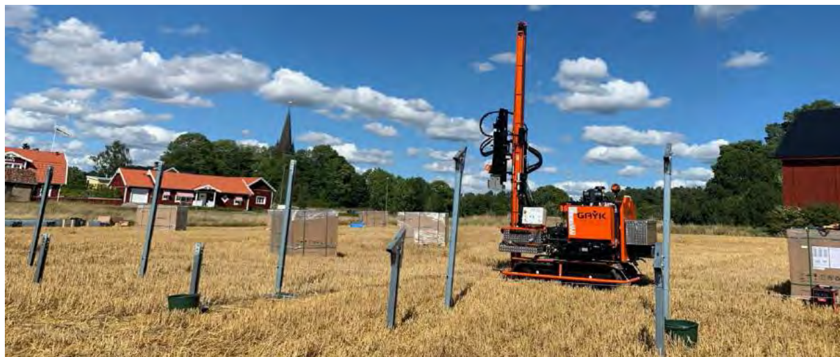
Figur 6. Montagesystem förankras med pålningsmaskin (©Svea Solar).
