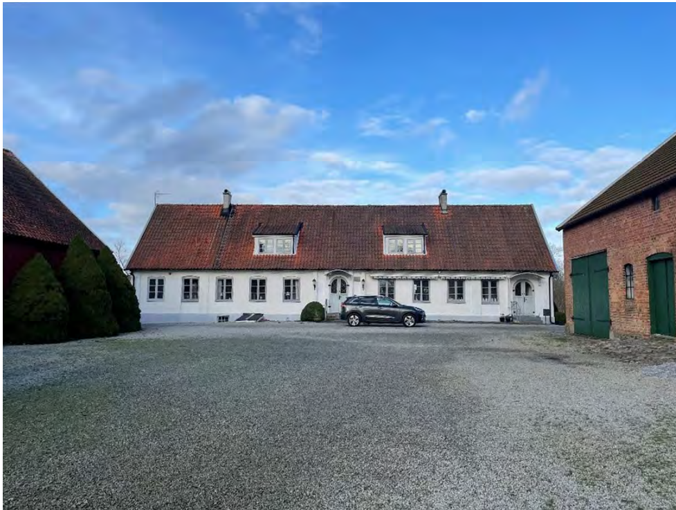
Figur 8. Mangårdsbyggnaden och gårdsplanen sett från söder.
