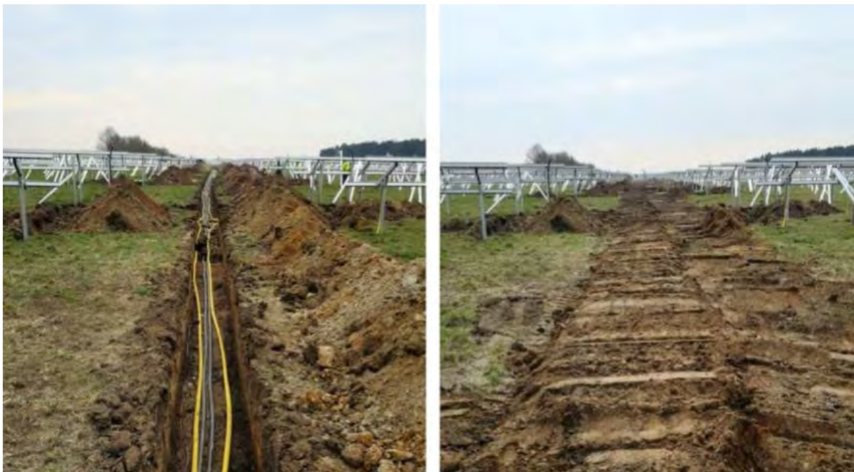
Figur 11. Schakt för kabelgångar (Svea Solar ©).
