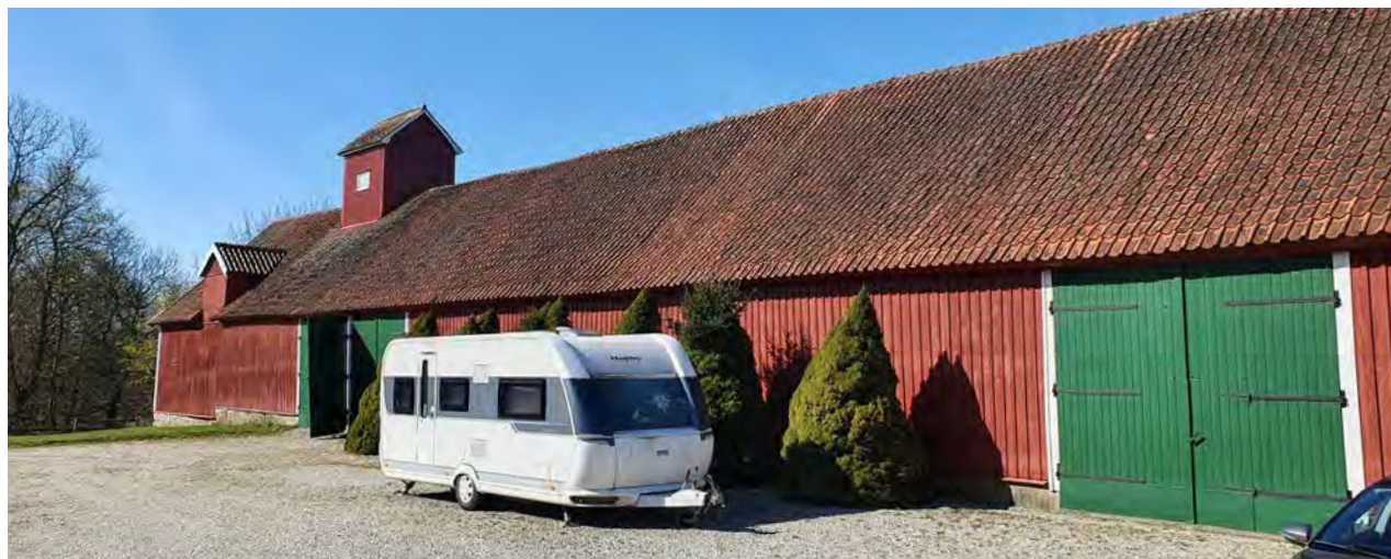
Logens fasad mot gårdsplanen.
