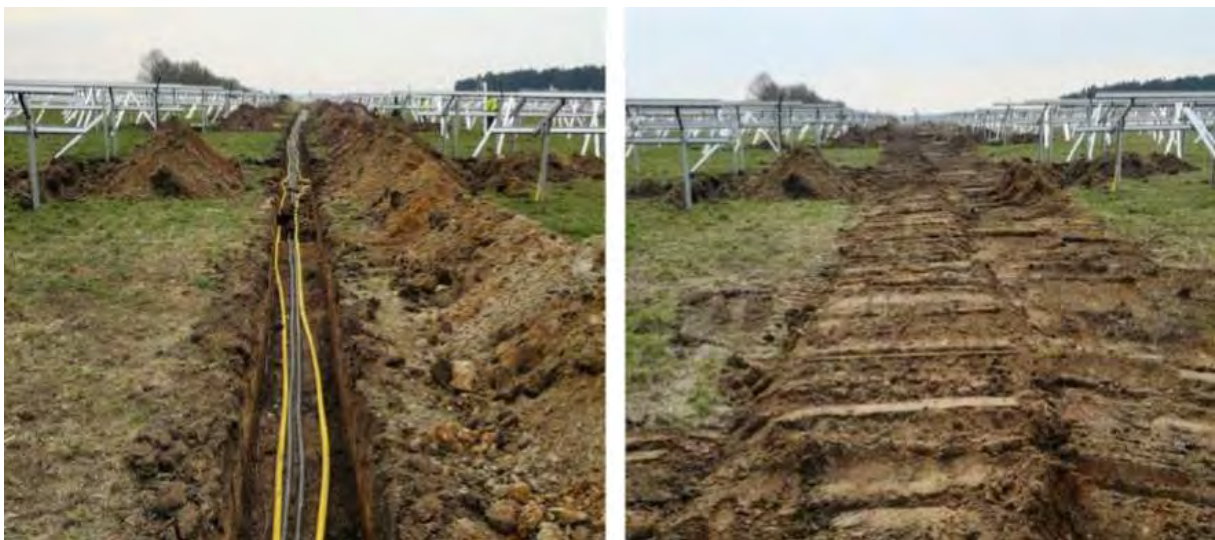
Figur 9. Schakt för kabelgångar (©Svea Solar).
