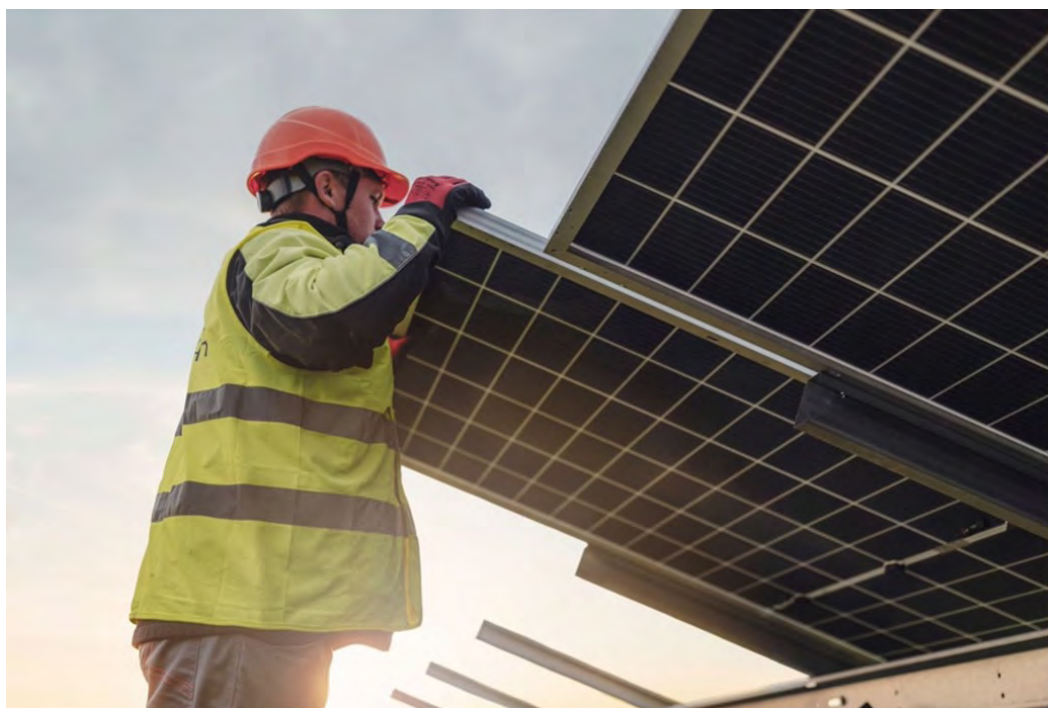
Figur 3.1: Montering av solpaneler (©Svea Solar)
