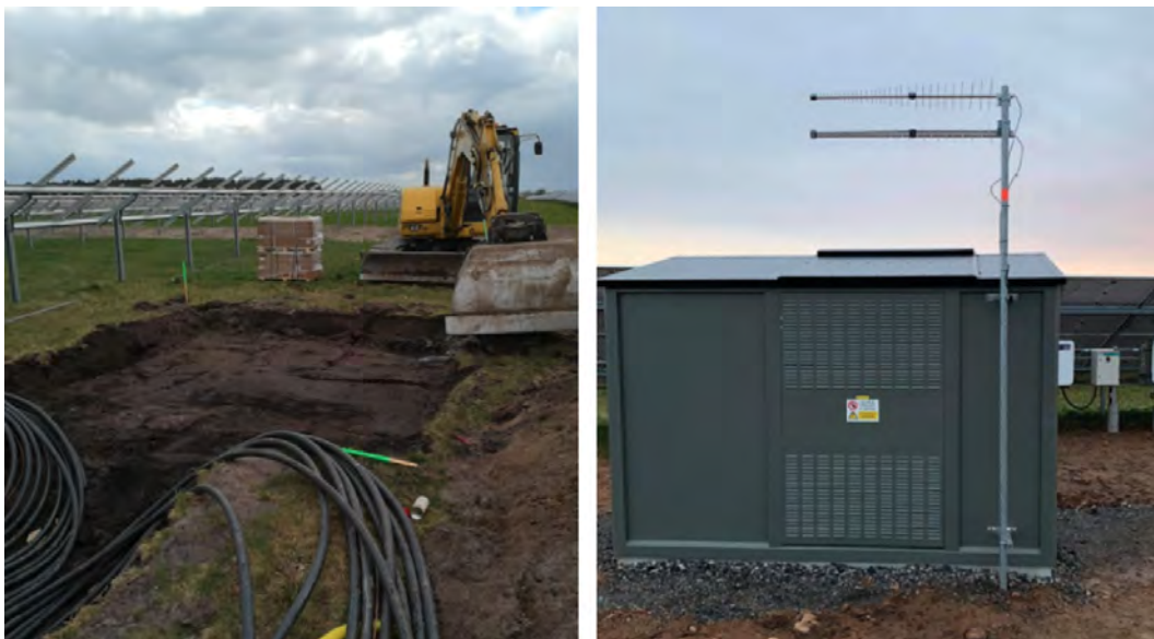
Figur 3.4: Vänster: markförberedelser för transformatorhus. Höger: transformatorhus (©Svea Solar).
