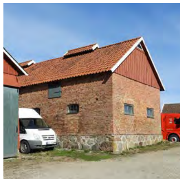
Svinstallets södra fasad och östra gavel.
