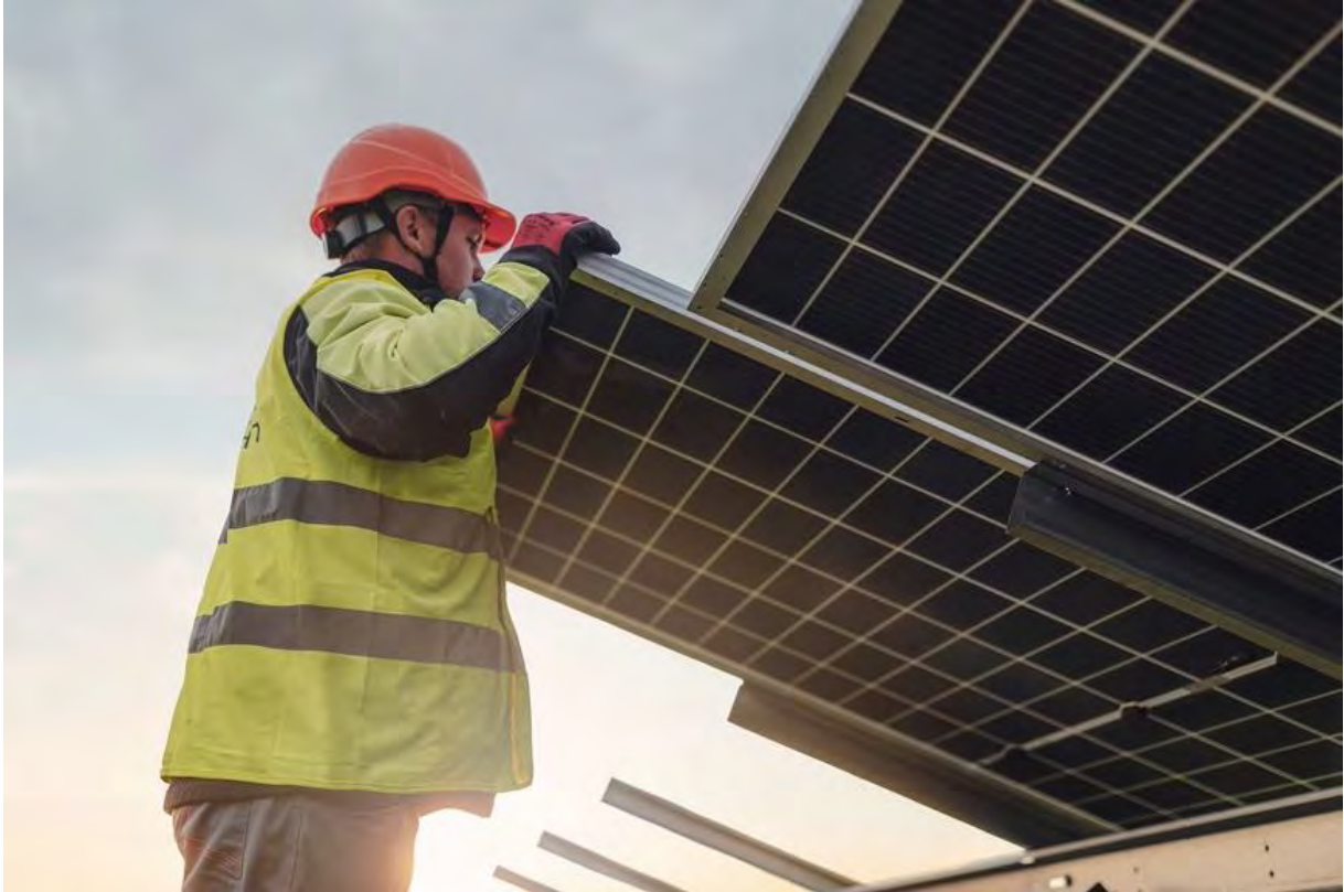
Figur 4. Närbild på montering av solpaneler (Svea Solar ©).
