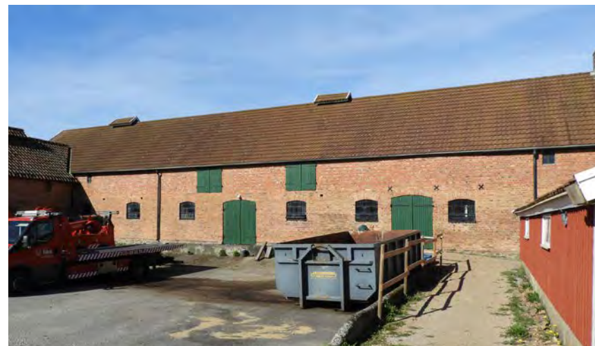
Kostallets fasad mot öster med gamla gödselplattan i förgrunden.
