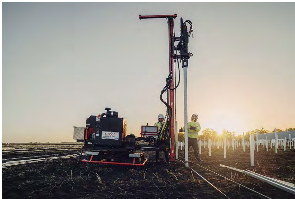
Figur 7. Montagesystem förankras med pålningsmaskin (Svea Solar ©).
