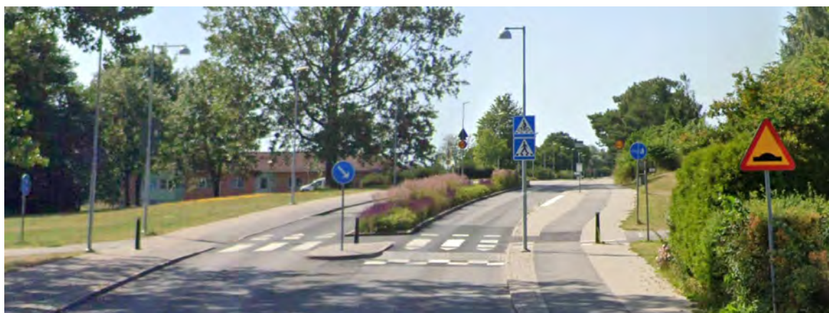
Figur 47. Hastighetssäkrad gång och cykelpassage på Solvägen, anpassad för busstrafik.
