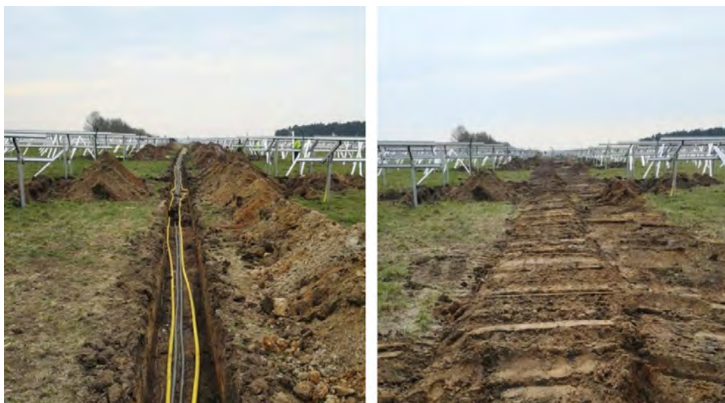
Figur 4.1: Schakt för kabelgångar (©Svea Solar).
