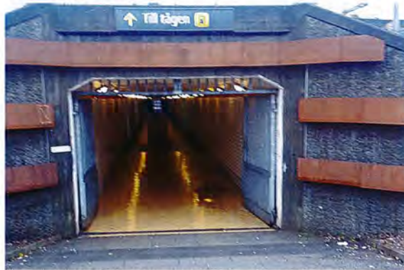
Otrygg gångtunnel vid stationsbyggnaden med dålig överblickbarhet och dålig synbarhet samt inga alternativa flyktvägar.
