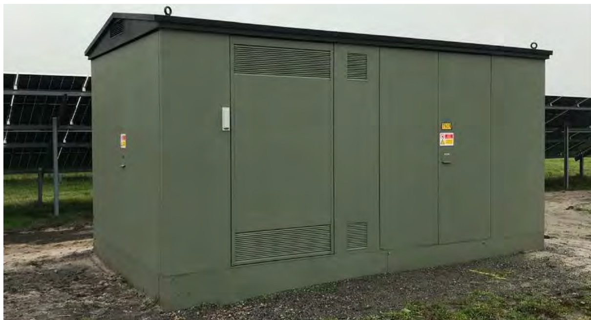
Figur 7. Transformatorhus. Bild från Bolagets solcellspark i Sjöbo (©Svea Solar).
