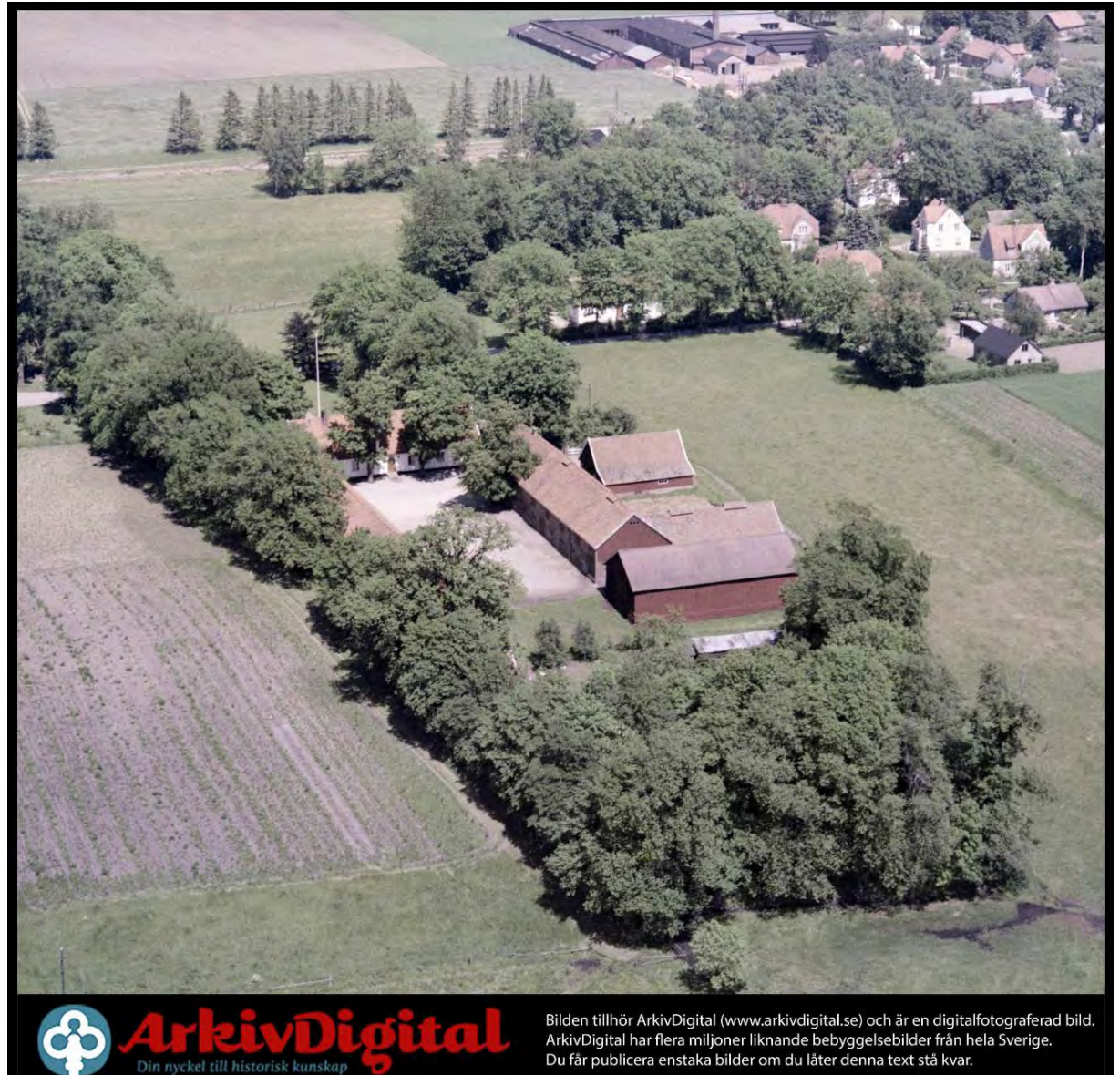
Flygbild över Johannesberg från söder 1956. Lummig grönska på fastigheten, till exempel flankeras huvudentrén på mangårdsbyggnaden av två träd. I bildens ovkant syns tegelbruket. Källa: ArkivDigital.
