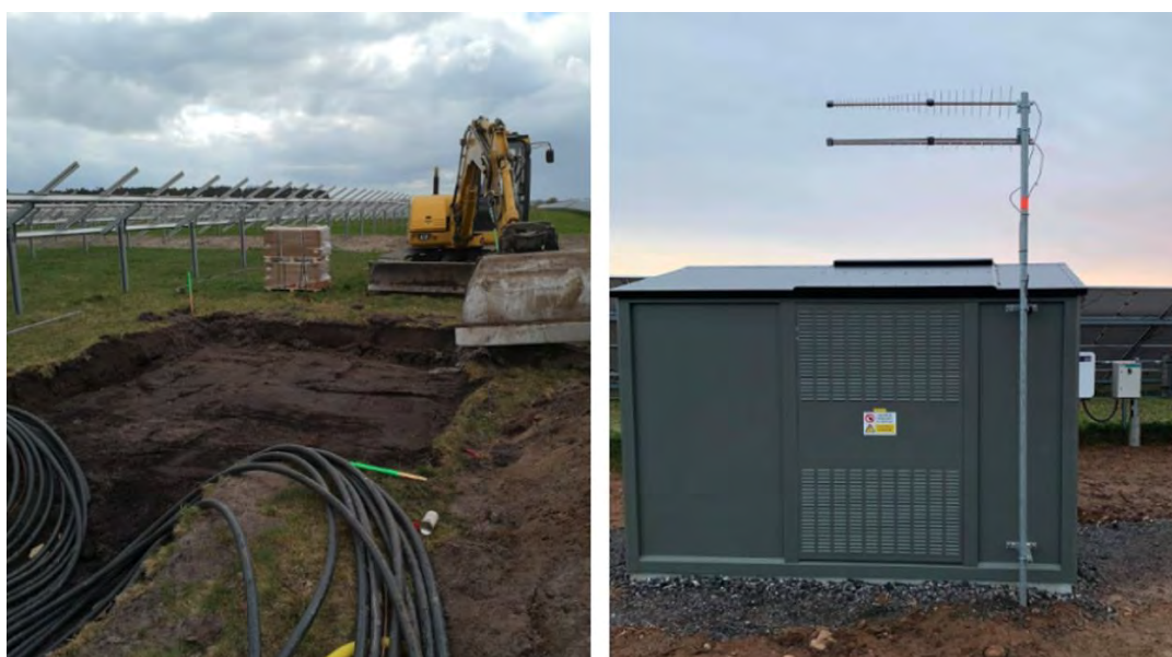
Figur 10. Förberedelser för transformatorhus (vänster) samt uppfört transformatorhus (höger) (Svea Solar ©).
