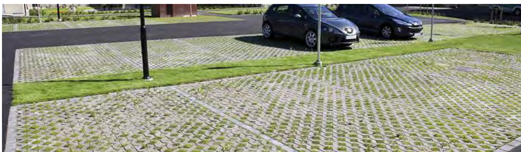
Figur 7-4. Parkeringsplats för bil utförd med gräsarmering som möjliggör för högre infiltration och mindre dagvattenavrinning (Benders 2019).
