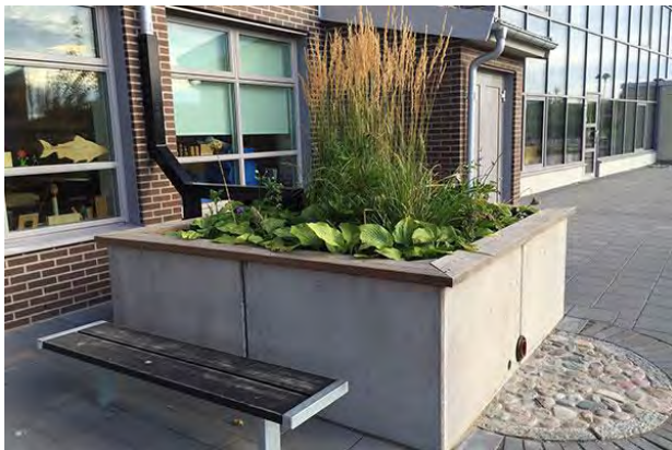
Figur 7-5. Upphöjd regnbädd ovan mark som även kan användas för till exempel plantering eller odling (Bara Mineraler 2019).
