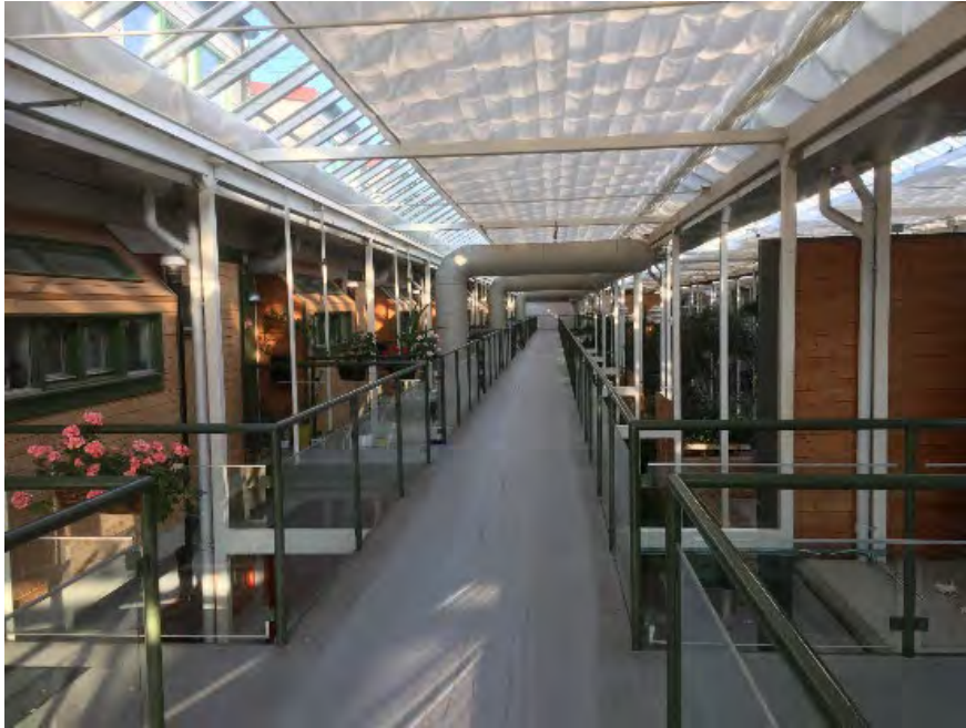
Figur 12. Inre loftgång i den befintliga byggnaden.
