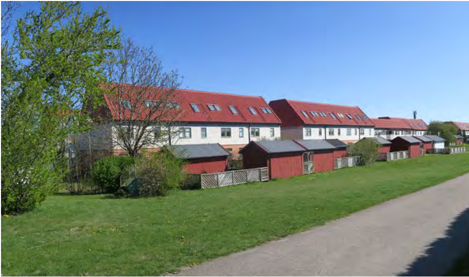
Södra längans fasader mot söder.
