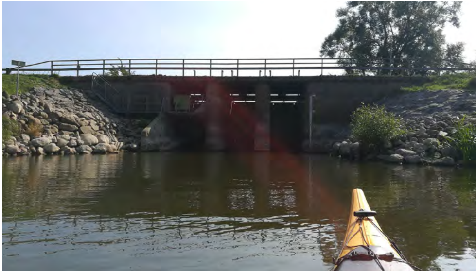
Figur 3.4: Regleringsdammen vid Vombsjöns utlopp i Kävlingeån från nedströmssidan. Dammen utgör ett definitivt hinder både för kajakpaddlare och fisk.
