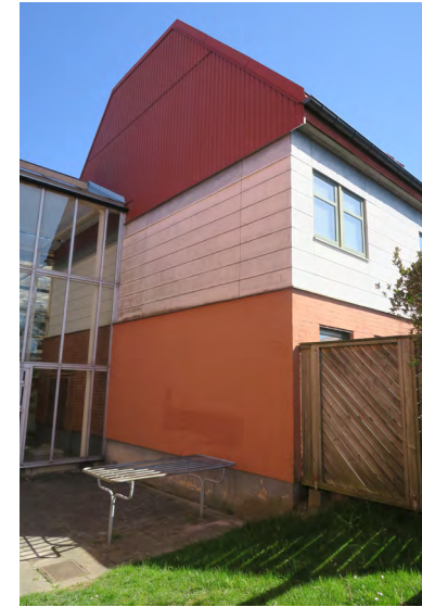
Detalj av gavelfasad i södra längan.
