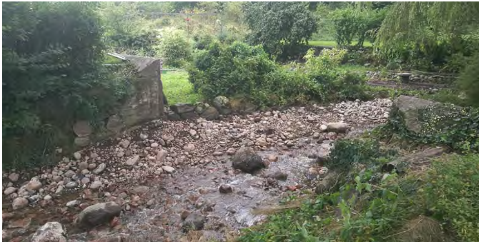
Figur 3.14: Vid Skönadals kvarn i Harlösa har ett vandringshinder för fisk och andra vattenlevande organismer rivits ut inom ramen för arbetet med Kävlingeåns vattenvårdsprogram. På bilden syns den återställda bäckfåran och rester av kvarndammen.
