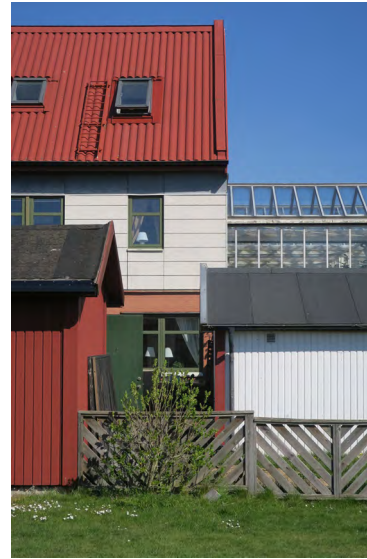
Detalj av bostadsfasad och förrådsbyggnader i södra längan.
