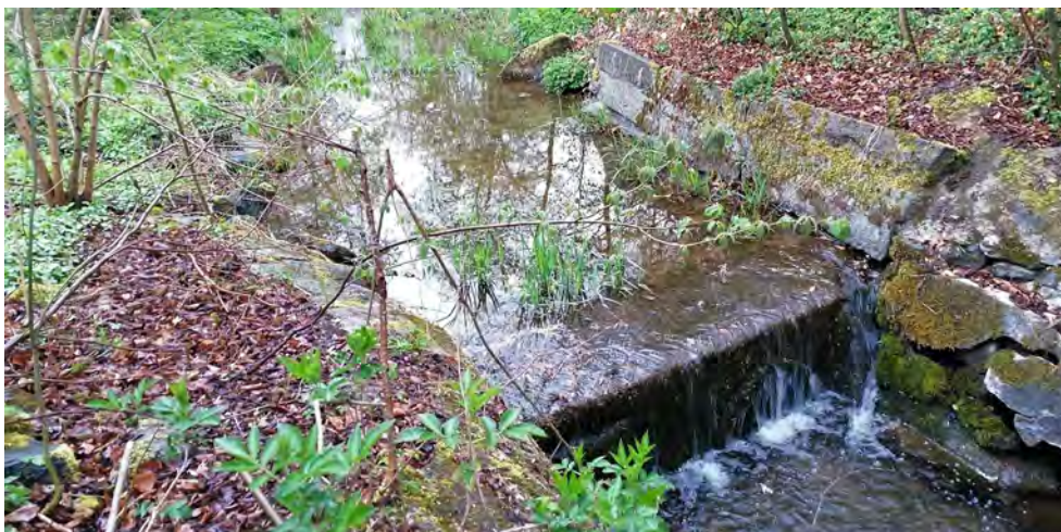
Figur 3.23: Dämmet i nedre delen av Grybybäcken som hindrar fisk och andra vattenlevande organismer att simma upp i Grybybäcken från Bråån under stora delar av året.
