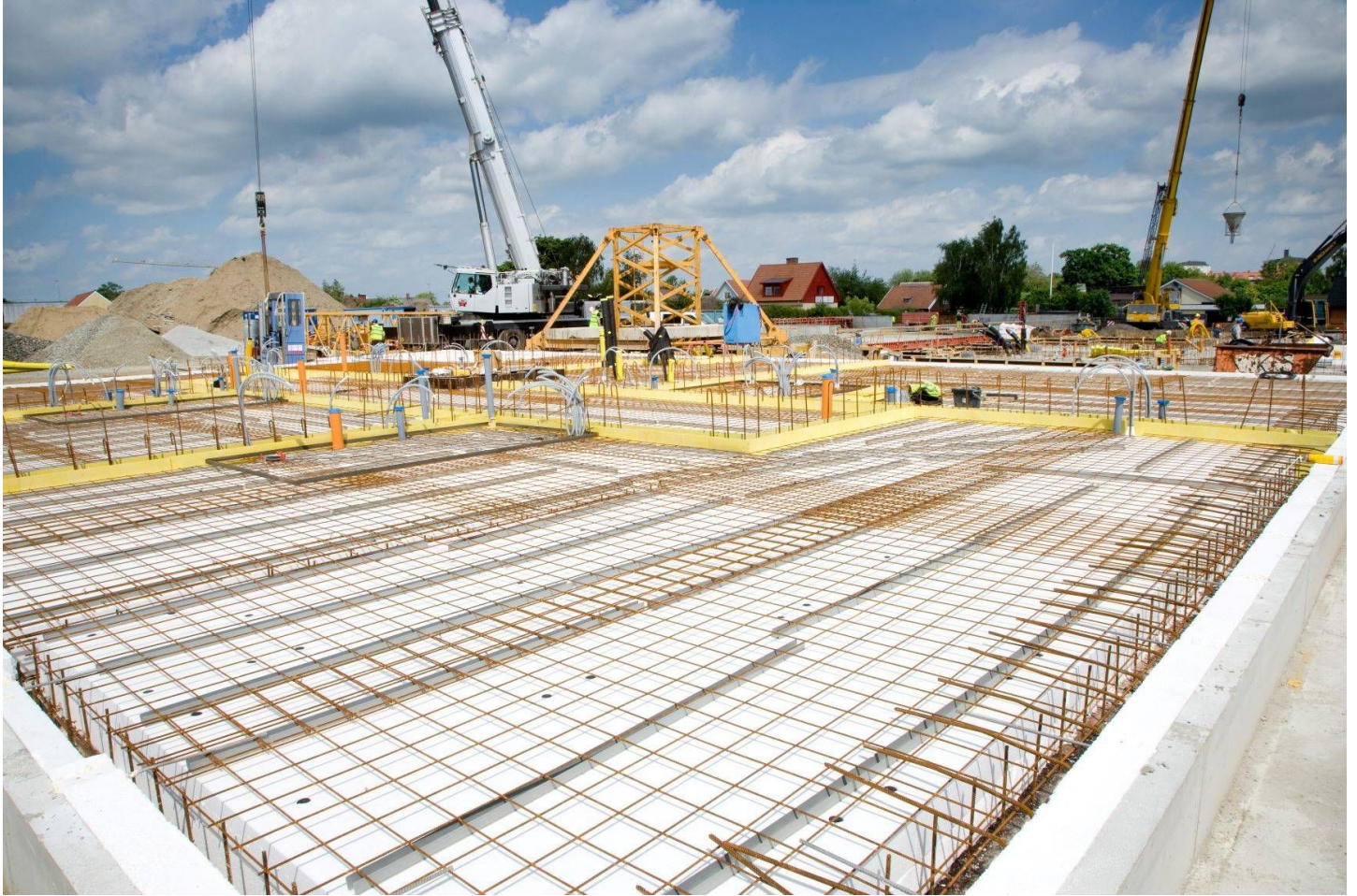
Byggarbetsplats i Eslöv
