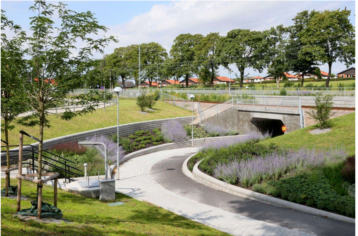
Järnvägsundergång Marieholms station
