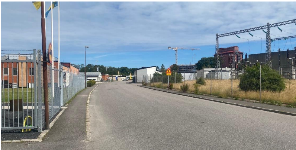
Figur 7. Vy över småindustrin, ställverket i den norra delen av Ystadsvägen.
