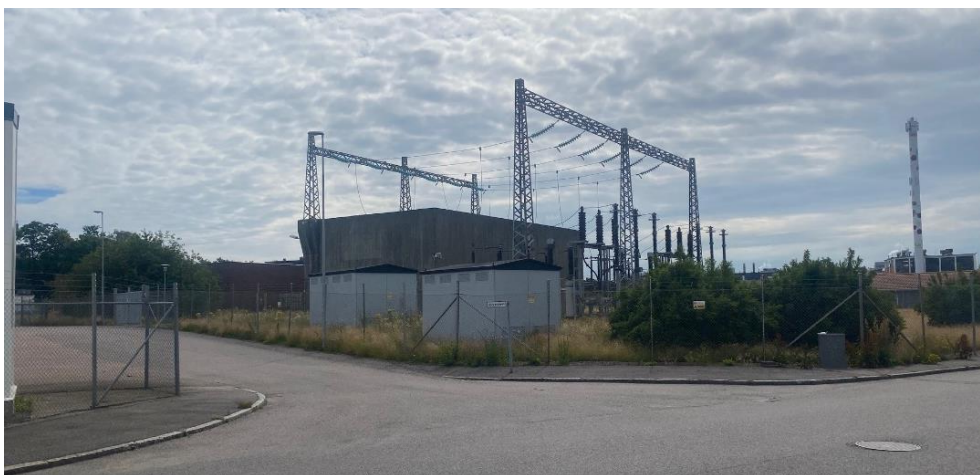
Figur 5. Ställverket som angränsar till fastigheten Rovän 8.
