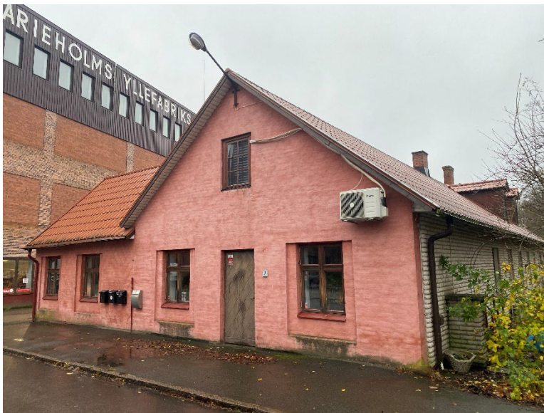
Figur 20. Disponentvillans fasad mot Yllegatan.
