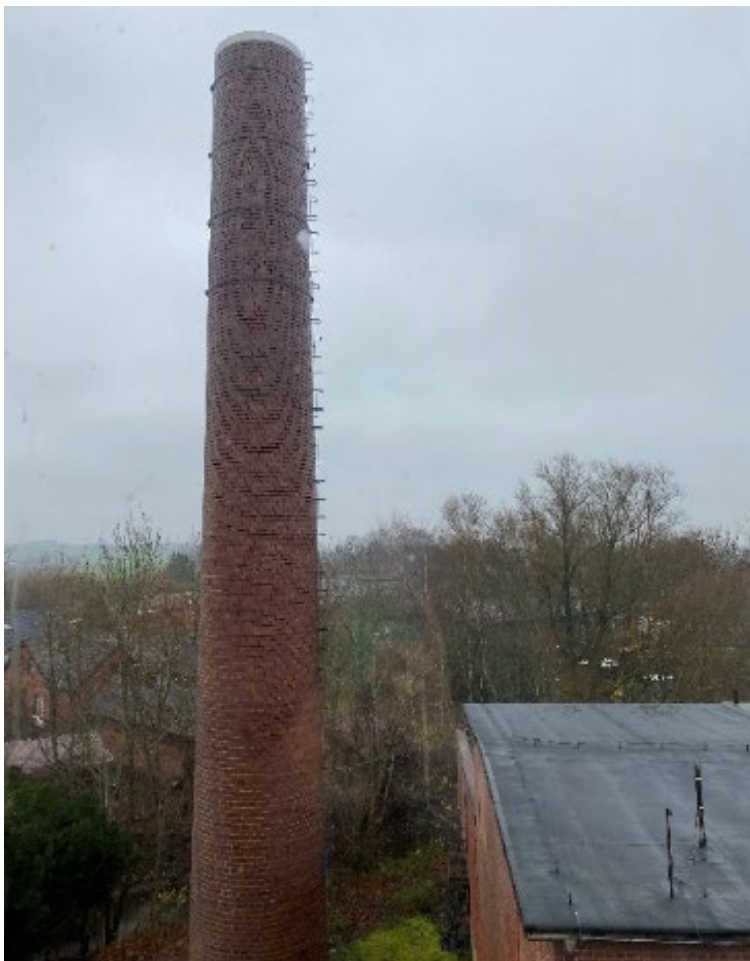
Figur 8. Panncentralens skorsten som ska bevaras.
