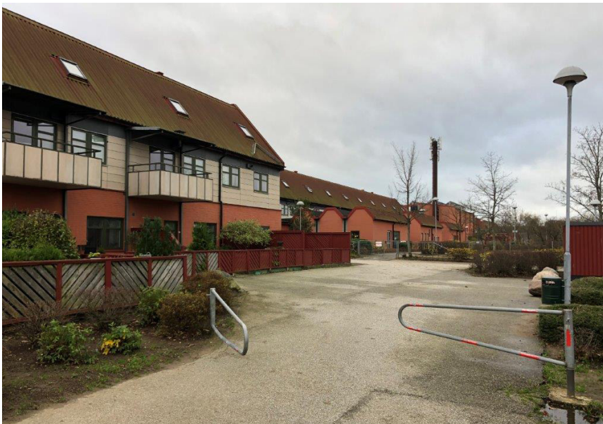
Norra längan, vy mot väster.
