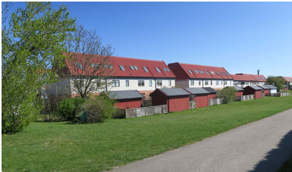
Södra längans fasader mot söder.
