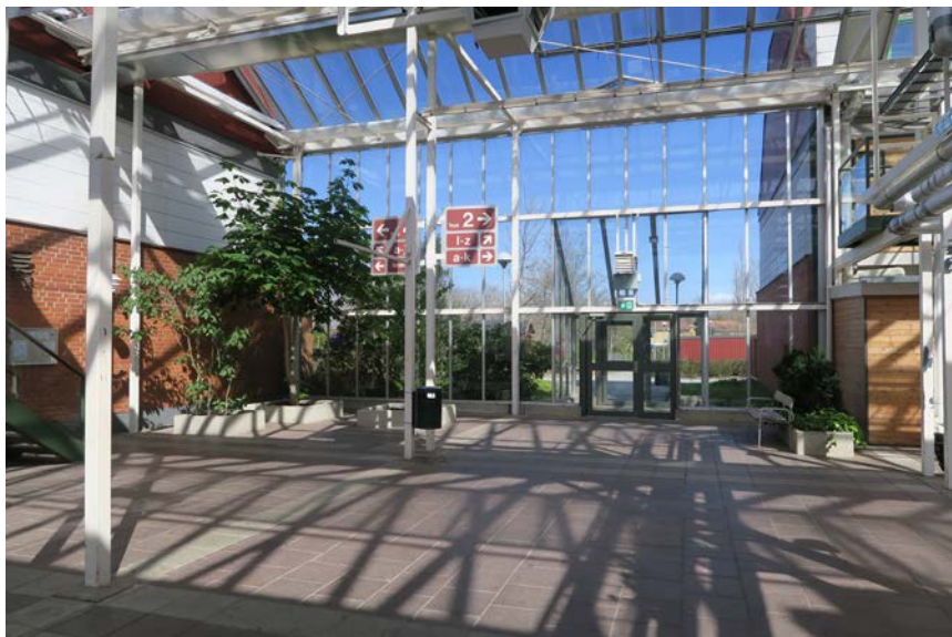
Glasgatan med entré mot norr.
