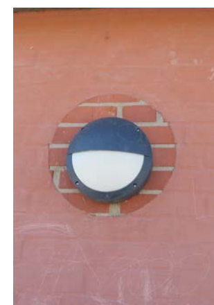
De ursprungligen bara tegelväggarna har senare slammats. Vid fasadarmaturer syns det ursprungliga utseendet.
