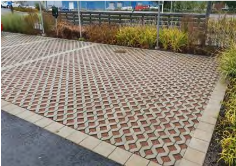
Figur 17. Exempel på permeabla ytor (Tyréns, 2021).
