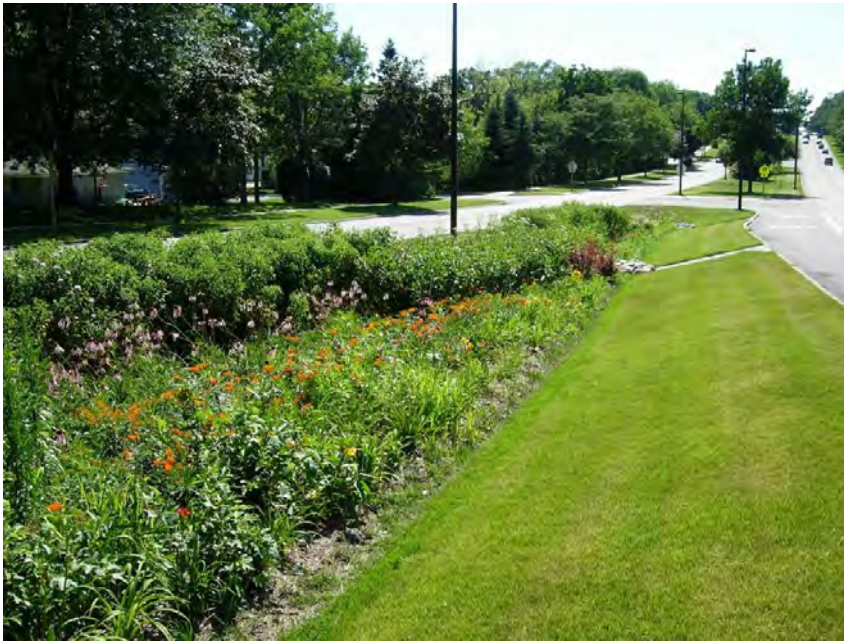
Figur 14. Exempel på svackdike med vegetation (källa: Milford)
