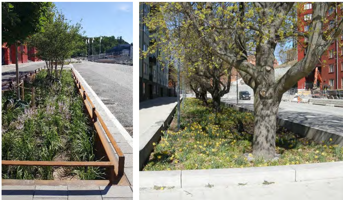
Figur 7 - Exempel på utformning av regnbäddar i gatumiljö (foto: Tyréns)
