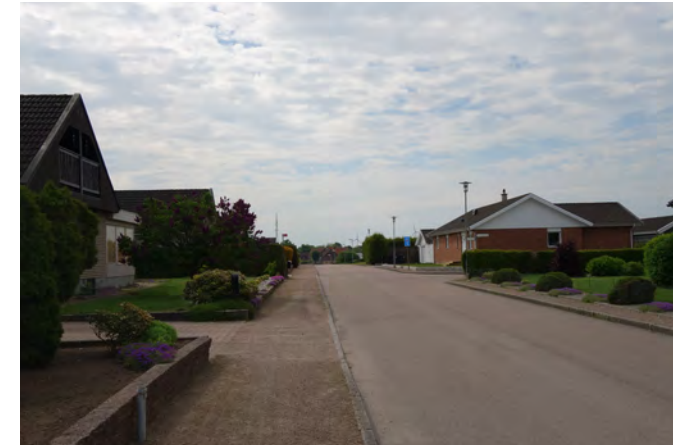
Tegelvägen, väst om planområdet. Remsa av stenmjöl/grus, körbana i asfalt. Bostäder på ömse sida. Gaturummets bredd ca: 7 m.
