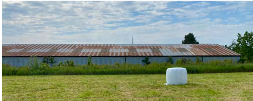
Byggnaden kloss an planområdet har en lång plåtklädd fasad. Den skapar en barriär mot järnvägen samtidigt som den bidrar till en rumslighet...
