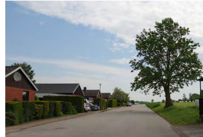
Ringvägen, norr om planområdet. Slänt mot gata, körbana i asfalt, kantsten och remsa av stenmjöl/grus. Gaturummets bredd ca: 10 m
