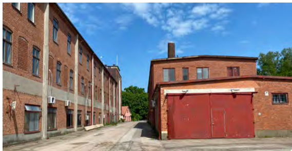
I Marieholms småskaliga bykärna utmärker sig yllefabriken med sina resliga tre- och fyrvåningsbyggnader.
