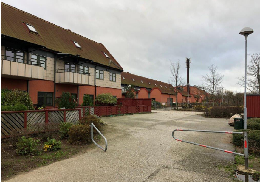
Norra längan, vy mot väster.
