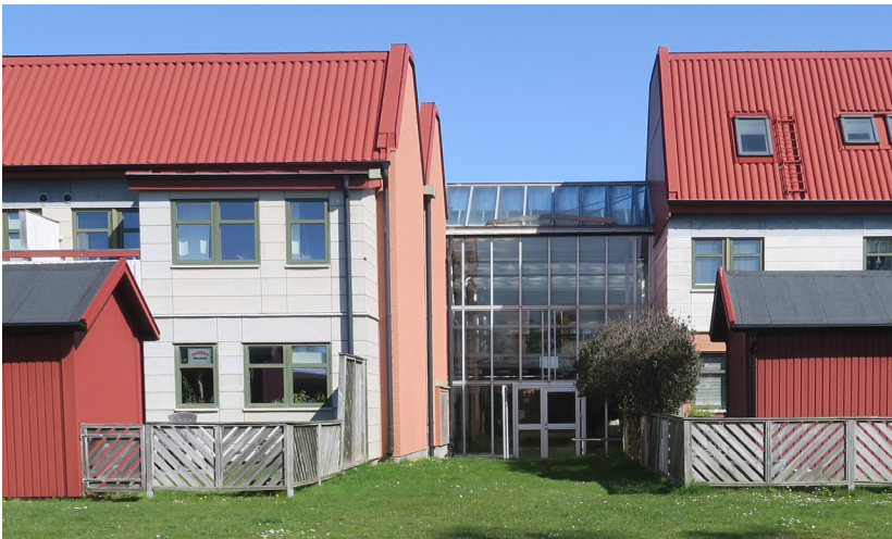
Sidoentré till glasgången, vid släpp i södra längan.
