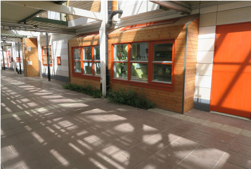
Skolans "exteriör" i den norra längan.
