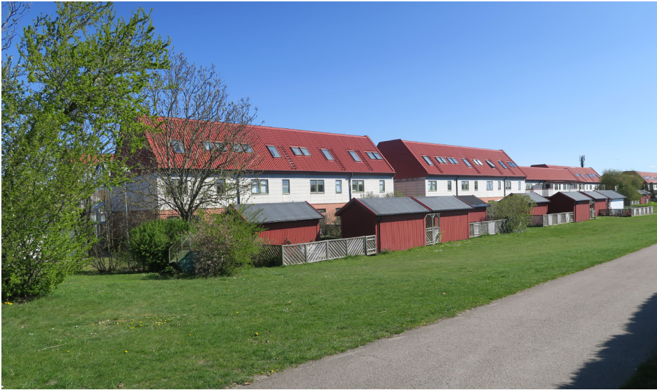
Södra längans fasader mot söder.
