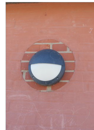
De ursprungligen bara tegelväggarna har senare slammats. Vid fasadarmaturer syns det ursprungliga utseendet.
