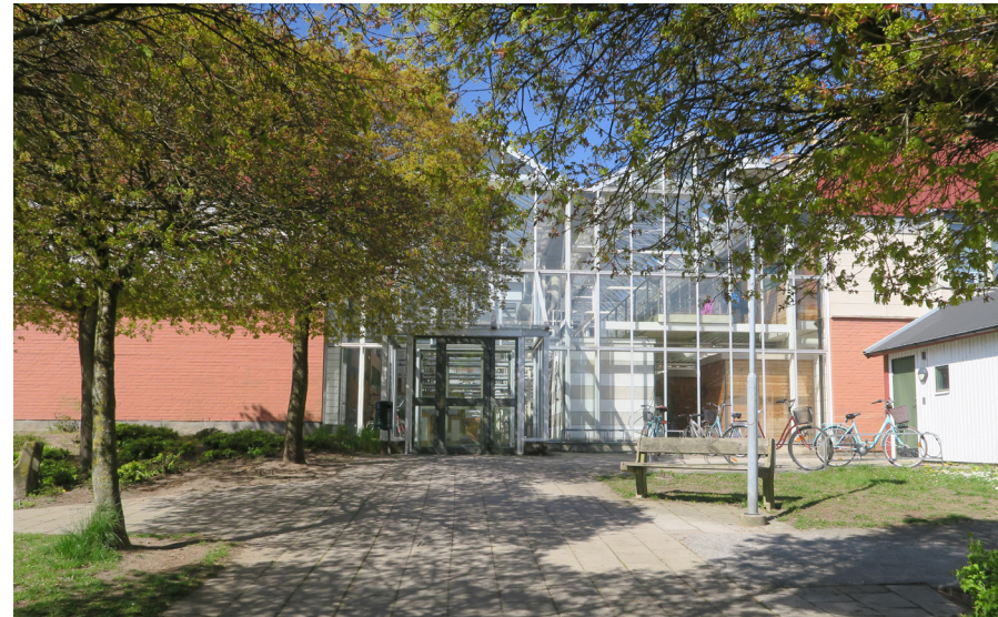
Entré till glasgången i öster.
