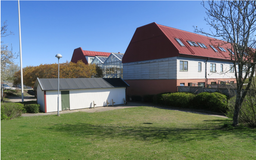
Norra och södra längornas västra gavelfasader, med den mellanliggande glasgången.
