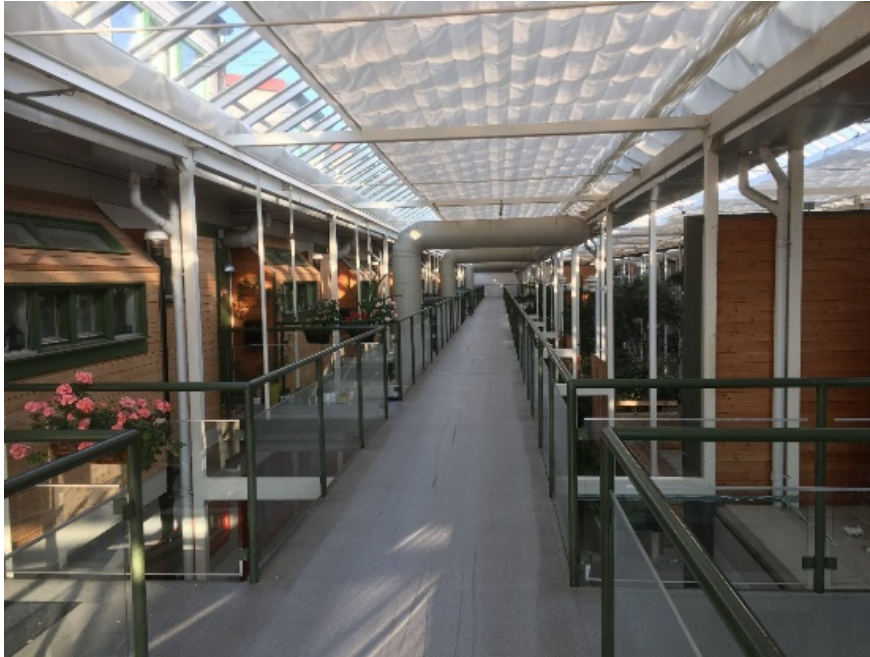
Figur 12. Inre loftgång i den befintliga byggnaden.
