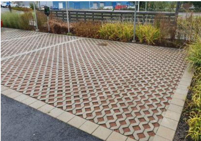
Figur 22. Exempel på permeabla ytor (Tyréns, 2021).
