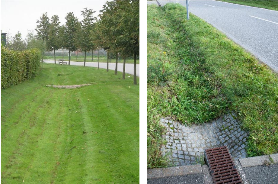
Figur 20. Exempel på svackdike (foto: Tyréns AB).
