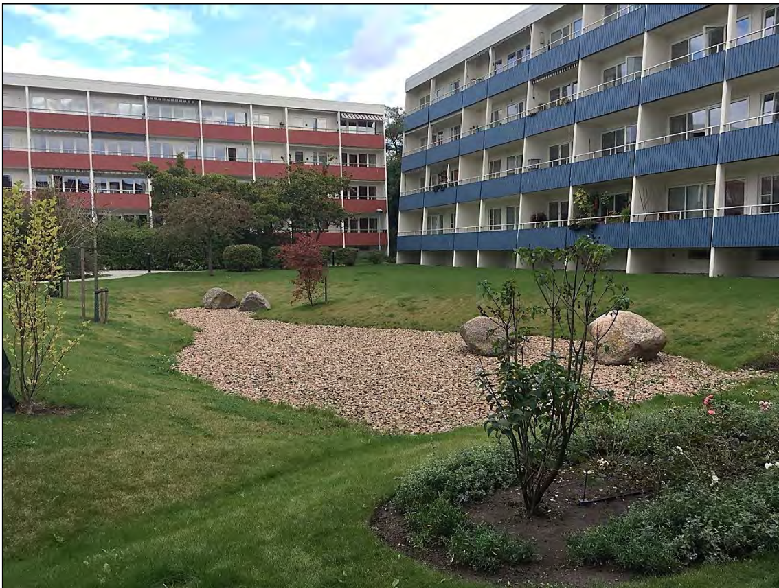
Figur 18. Exempel på en nedsänkt översvämningsyta (Tyréns, 2021).
