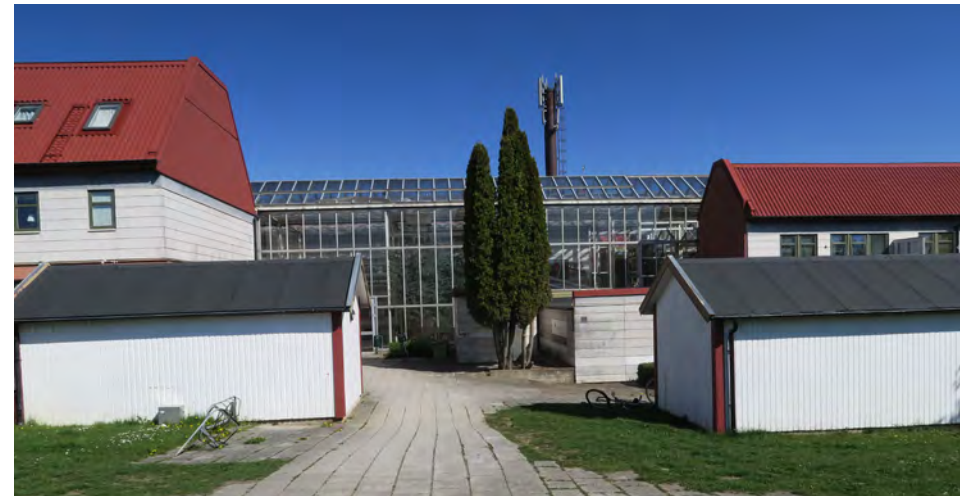
Större släpp i södra längan, där glasgången blir synlig.
