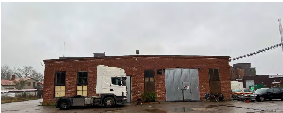
Figur 10. Fotot högst upp till vänster visar den äldre byggnadsdelen av Färgeriet med äldre fönstersnickerier, murade listverk och Tympanon. Fotot högst upp till höger visar mötet mellan den ursprungliga byggnaden och den senare tillkomna byggnadsdelen. Bilden längst ner visar Färgeriets västra fasad.
