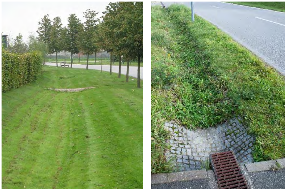
Figur 20. Exempel på svackdike (foto: Tyréns AB).
