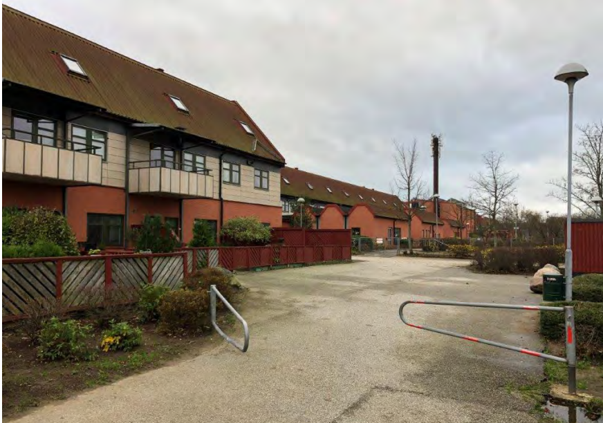
Norra längan, vy mot väster.
