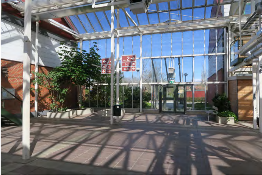
Glasgatan med entré mot norr.
