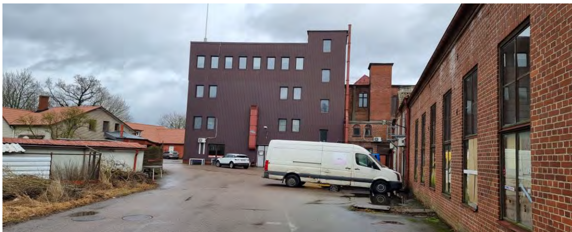
Figur 4.6 visar del av den gamla Yllefabriken med vy mot öst.
