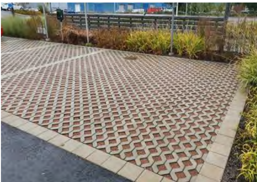
Figur 22. Exempel på permeabla ytor (Tyréns, 2021).
