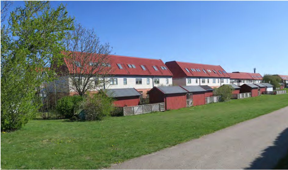
Södra längans fasader mot söder.
