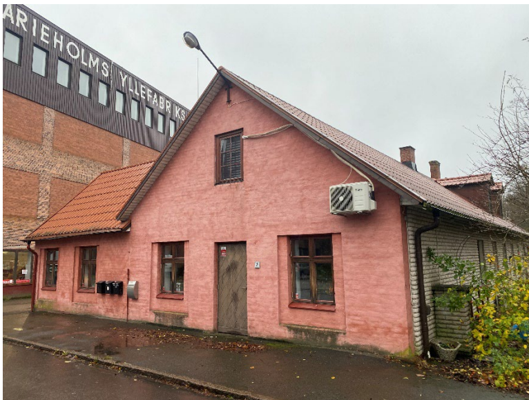
Figur 20. Disponentvillans fasad mot Yllegatan.
