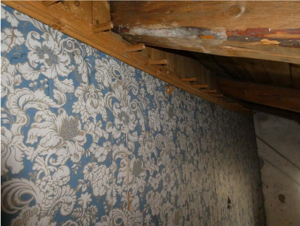
Fasanen 10, kattvind en trapp upp, med äldre tapet och knoppbräda med täljda knoppar.
