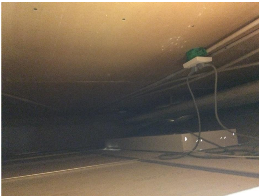
Figur 19 Foto av utrymmet ovan undertaket visar att gipsskivor fästs i äldre innertak.
