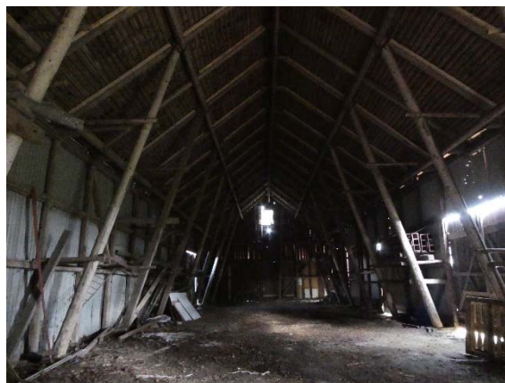
Bostadshusets tegelfasad mot trädgården, ritsad fog. Loge med silor.
