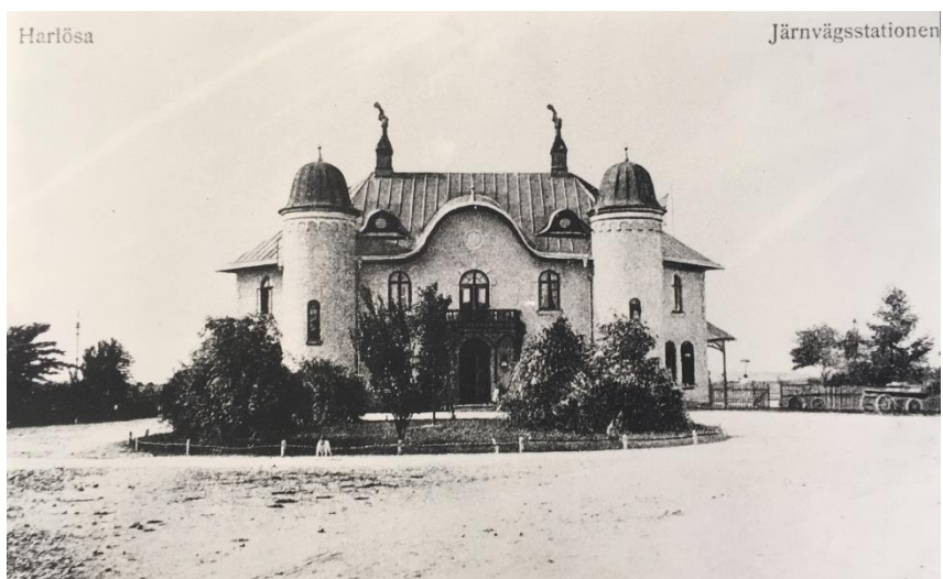
Figur 4 Harlösa stationshus, gatusidan, äldre foto i Harlösa bibliotek.
