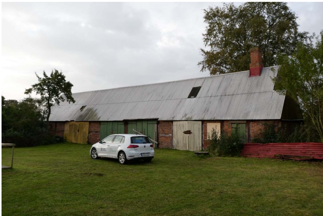
Korsvirke i västra längan. Den mindre ekonomibygnaden.
