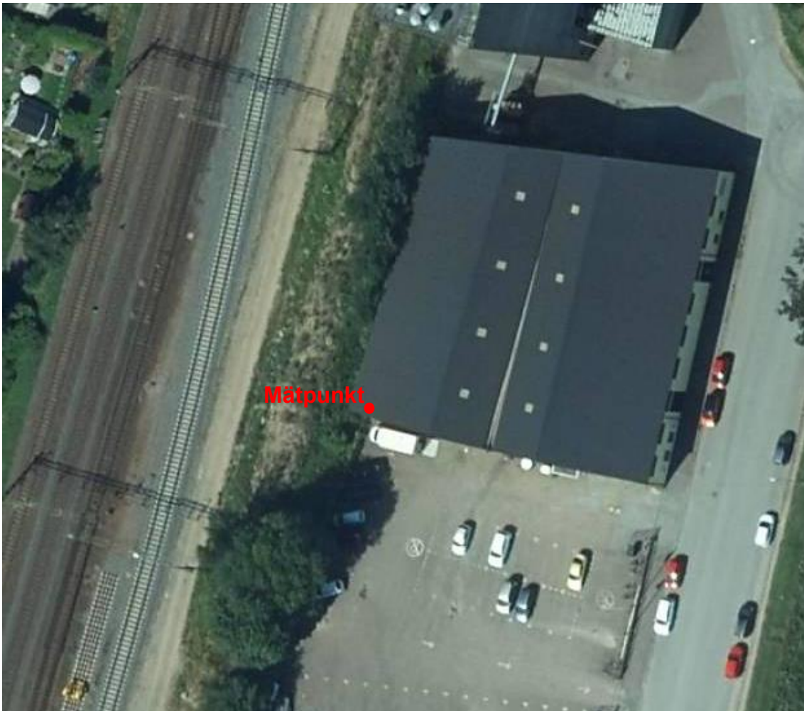
Figur 4. Mätpunkt på befintlig byggnads grundmur ca 20 meter från närmaste spårmit.
