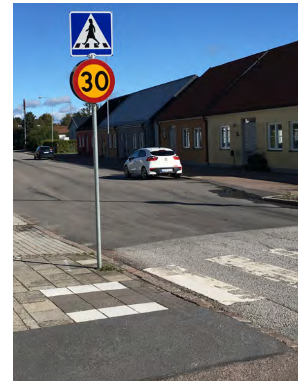
Nedsänkt kant vid övergångsställe.
