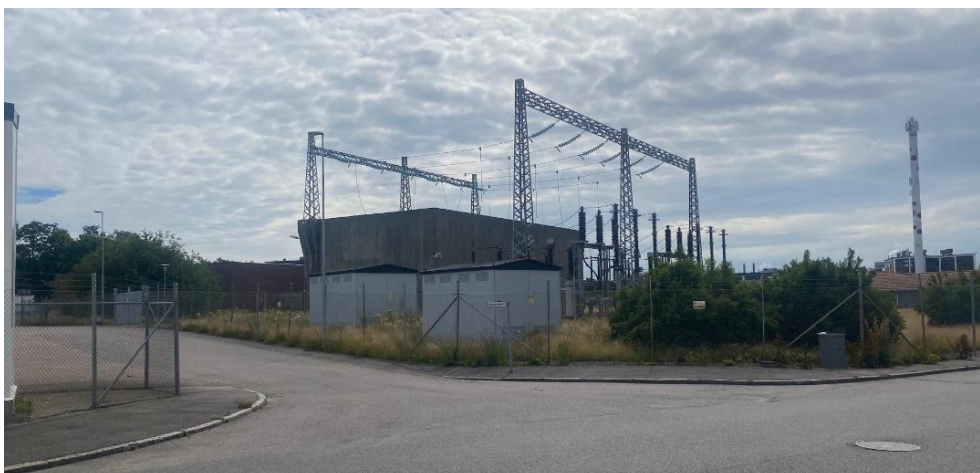
Figur 5. Ställverket som angränsar till fastigheten Rovän 8.
