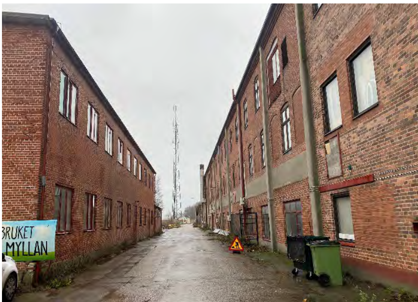
Figur 7. Yllegatan med Panncentralen till vänster och Fabriken till höger i bild.
