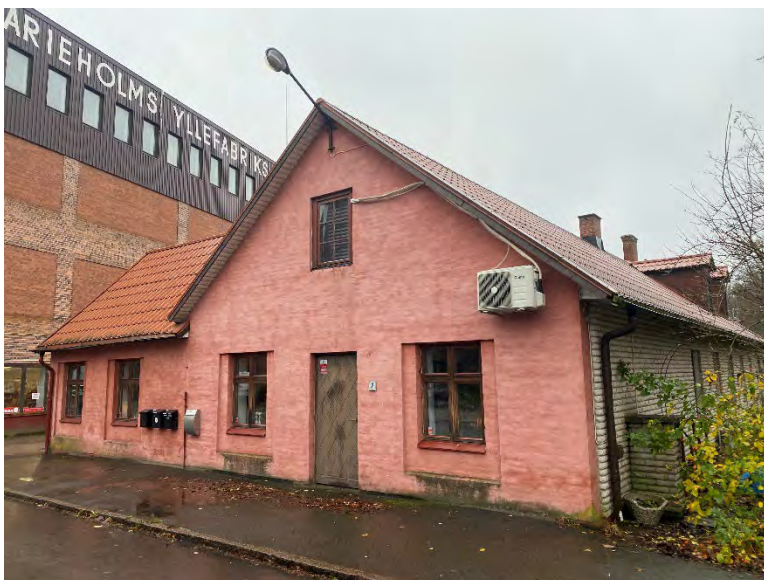
Figur 20. Disponentvillans fasad mot Yllegatan.
