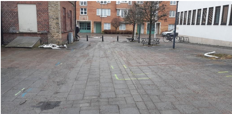
Figur 3.4: GC väg Återvändsgränd med vy mot väst/Södergatan. Till vänster av bilden visas en del av Lilla Teatern.
